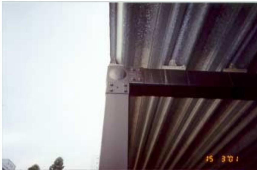
Figura 3.17 – Ligação entre uma viga e uma coluna constituída de nó de aço, ressaltando-se o acabamento em plástico da abertura circular.
