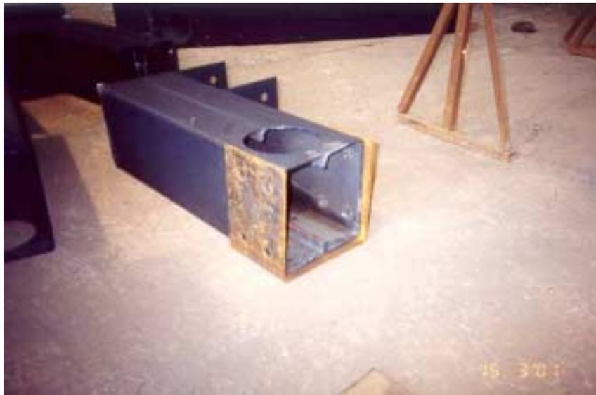
Figura 3.14 – Detalhe da ligação da viga com a luva.
