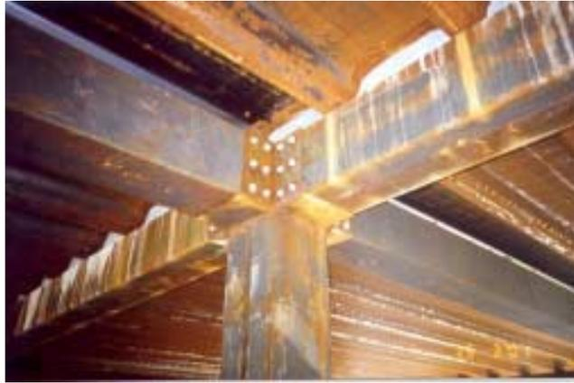
Figura 5.9 – Detalhe da utilização da luva estrutural de aço nas ligações da colunas e das vigas metálicas.
