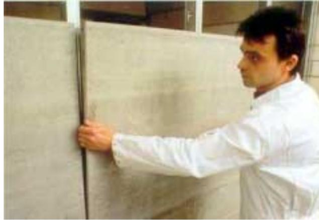
Figura 2.10 – Instalação da placa cimentícia nos montantes galvanizados (Knauf, 1999).
