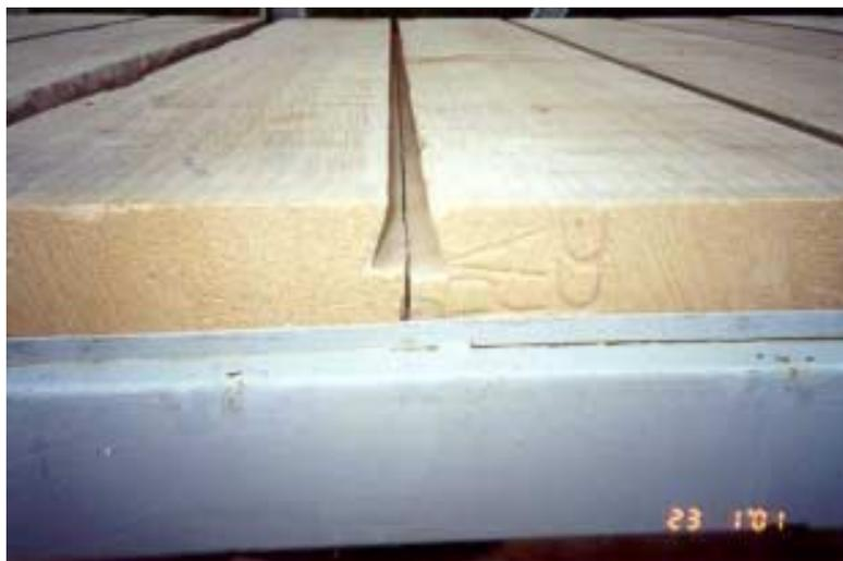
Figura 5.29 – Detalhe entre os painéis de concreto celular autoclavado onde será colocado o “grout” para proporcionar maior solidariedade à laje.
