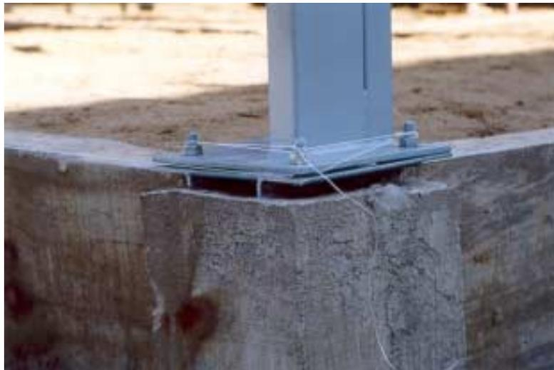
Figura 5.2 – Base de coluna metálica sobre bloco de fundação
