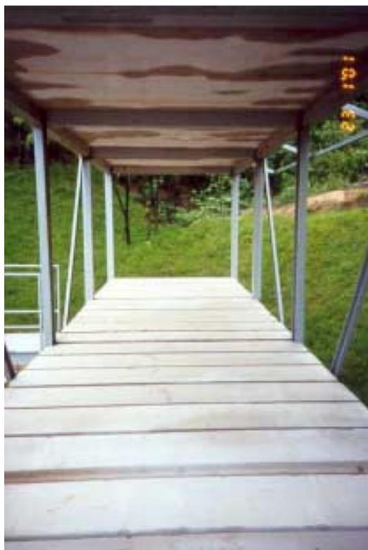
Figura 5.30 – Aspecto geral da laje constituída de painéis de concreto celular autoclavado.
