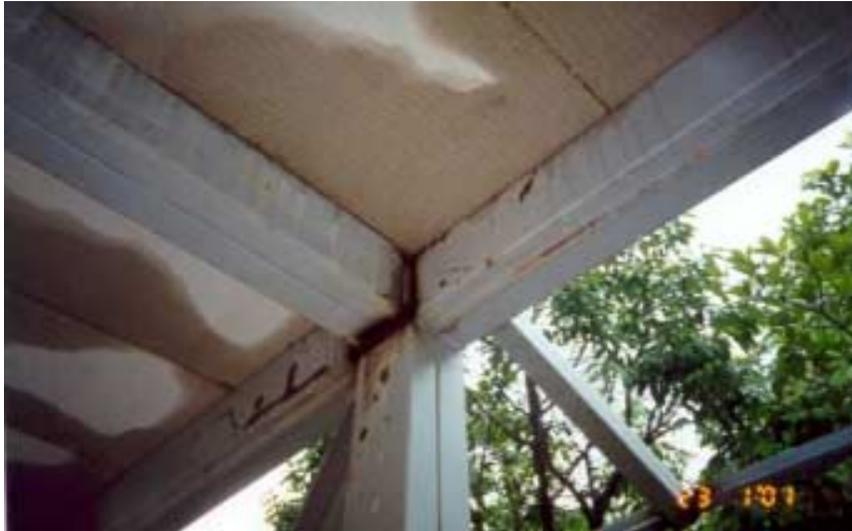
Figura 5.21 – Detalhe da ligação soldada entre coluna e vigas
