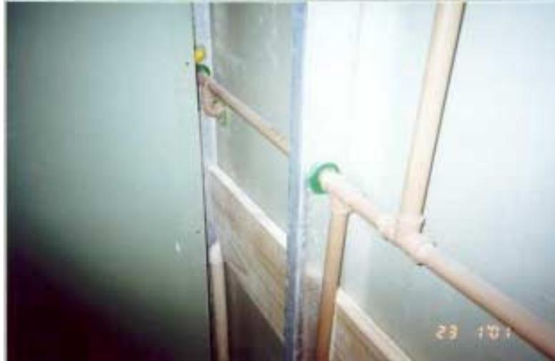
Figura 5.41 – Detalhe do protetor plástico para eletrodutos e mangueiras flexíveis
