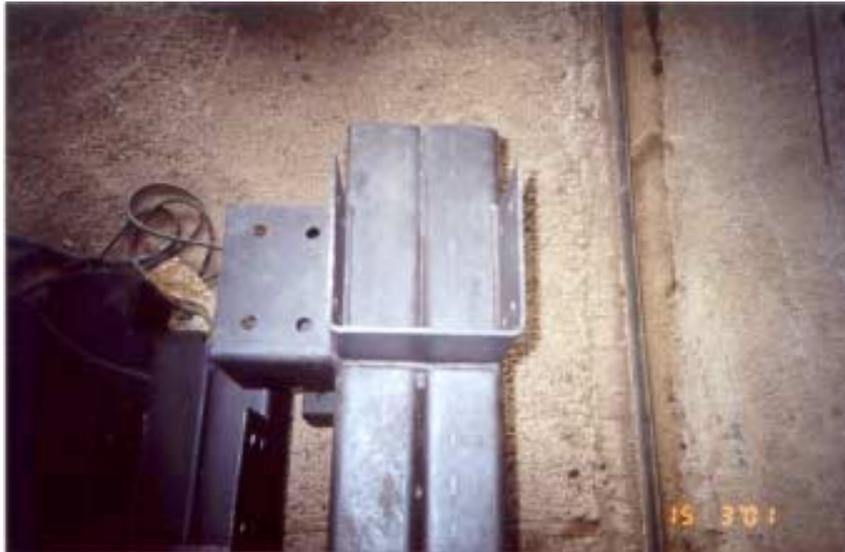
Figura 3.11 – Detalhe das luvas estruturais soldadas à coluna.
