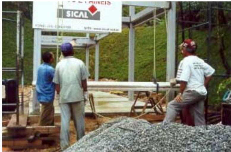
Figura 5.26 – Preparação para elevação do painel por meio de cordas e roldanas.
