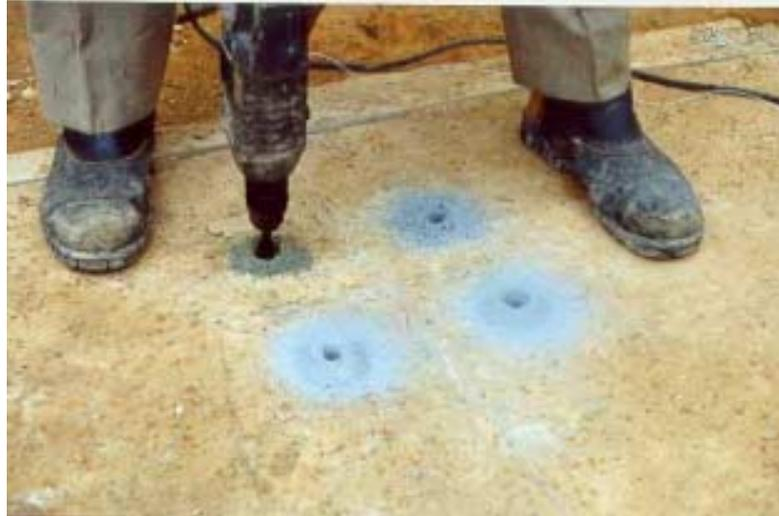
Figura 5.3 – Detalhe da furação dos blocos de fundação
