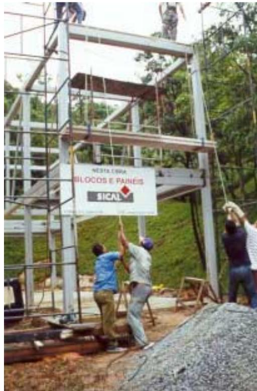
Figura 5.27 - Elevação dos painéis de concreto celular autoclavado.
