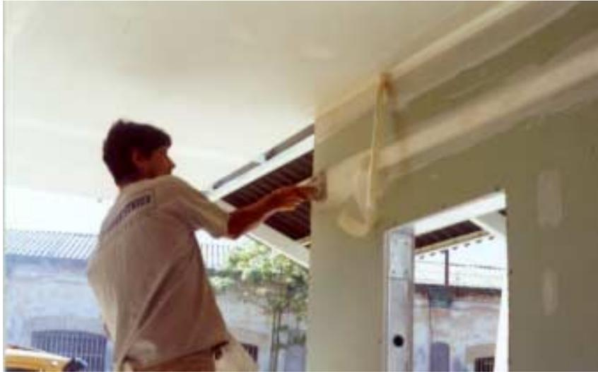
Figura 5.42 – Detalhe da fixação da fita de papel microperfurada e da massa de rejuntamento.
