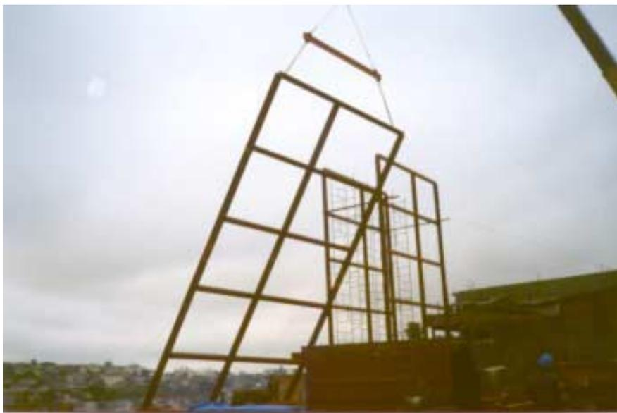
Figura 5.17 – Exemplo de montagem de pórticos pré-montados no canteiro de obras.
