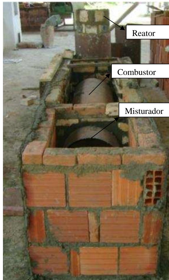
Figura 3.3: Gaseificador em construção.
