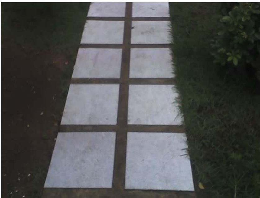
Figura 14- Piso externo fabricado com material longa vida.
