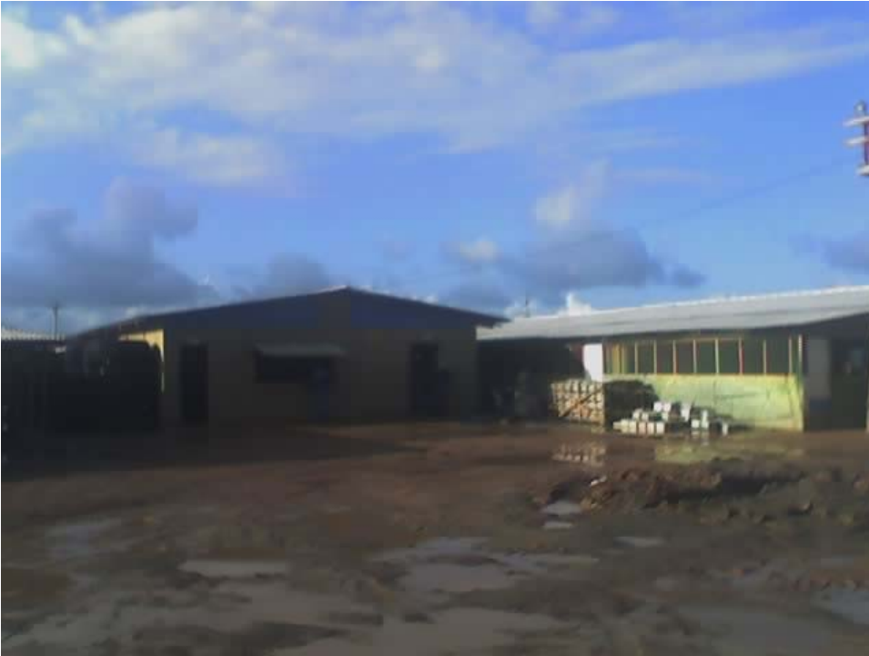
Figura 15 -Galpões que são construídos com madeira e telhados de fibrocimento podem ser substituídos por material plástico reciclável.
