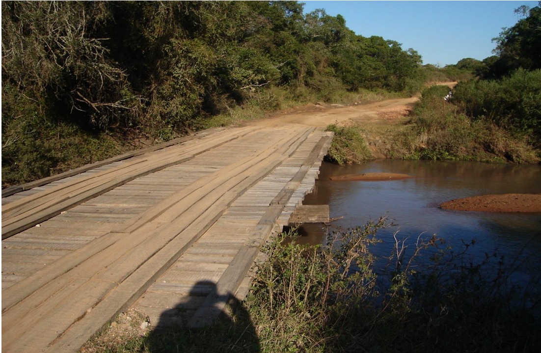
Fotografia 1: Estrada de acesso ao Santa Alice – Herval/RS.
