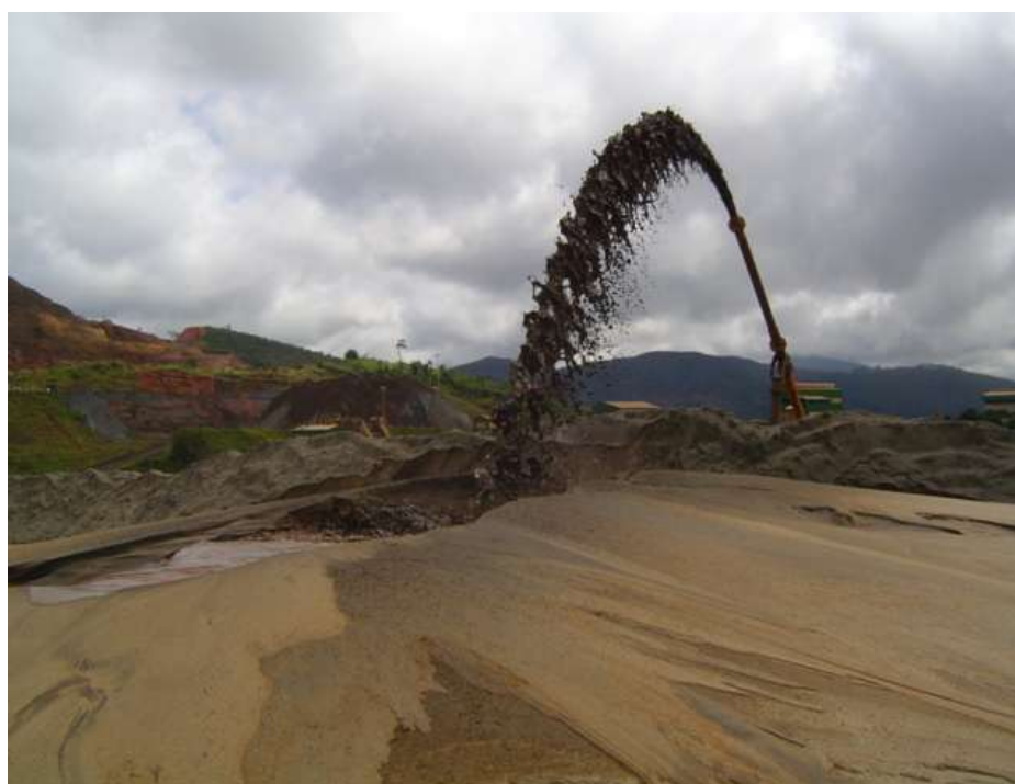
Figura 4.5 – Vista do dique e da praia de deposição da Pilha do Monjolo.
