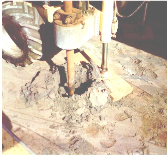
Figura 4.3 – Cravação dos trados mecânicos
