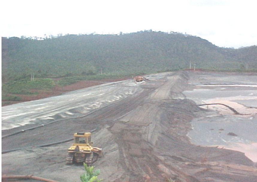
Figura 4.6 – Vista do talude de montante e da praia de deposição da Barragem de Campo Grande
