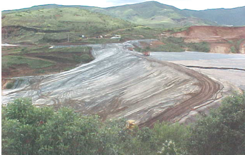
Figura 4.4 – Vista do talude de jusante da Barragem do Doutor
