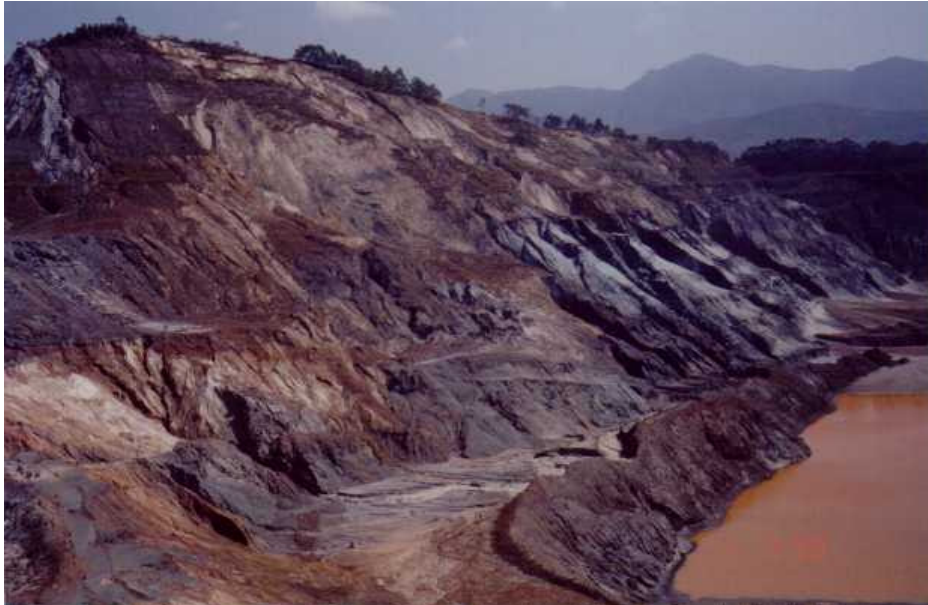
Foto 1.2 - Detalhe dos taludes erodidos de filito/itabirito da Cava do Germano.
