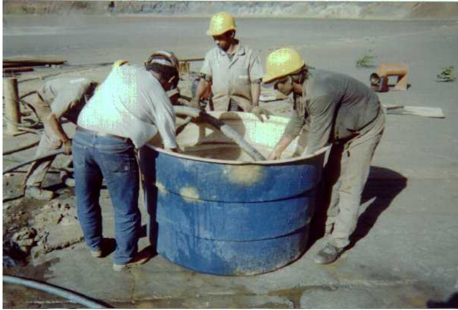
Foto 5.6 -Preparação da bentonita em tanque para aplicação no furo de sondagem.
