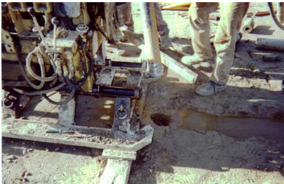
Foto 5.8 -Preparação do corte com lâmina wídia para aplicar o revestimento tipo HW.
