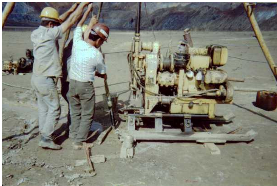
Foto 5.5 - Colocação da sonda pressiométrica no furo já executado.
