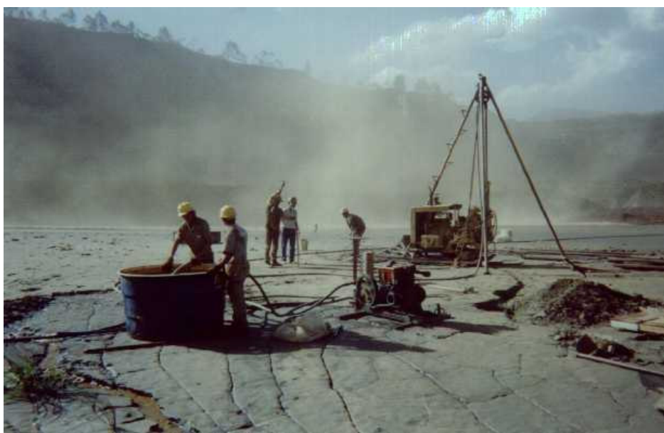
Foto 5.2 - Vista do equipamento de sondagem mista e preparo da lama bentonítica para o ensaio pressiométrico (furo 9A).
