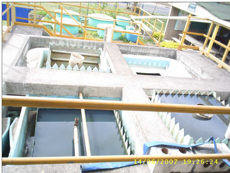
Figura A.6 – Decantação primária convencional
