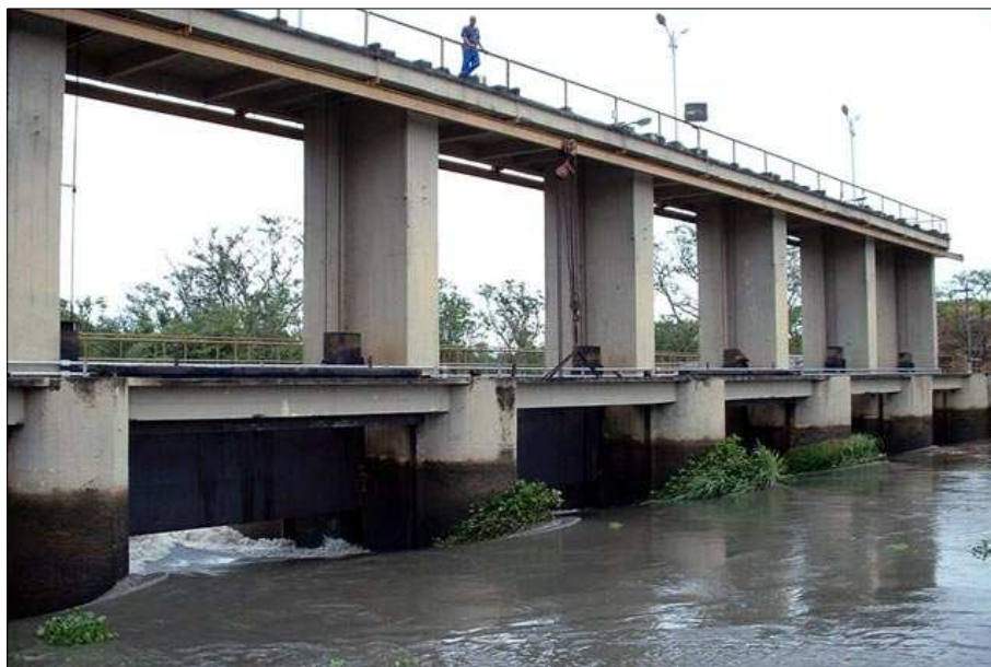
Figura A.7 – ETA Guandu captação - CEDAE
