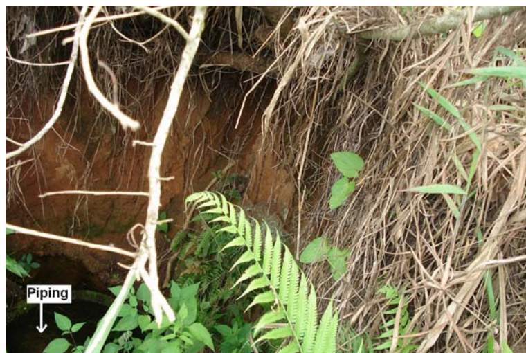
Figura 2. 7 – Erosão interna "piping" (Bananal, SP).
