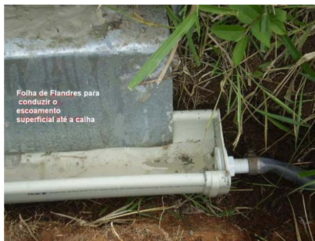
Figura 3. 13 – Detalhe da calha.
