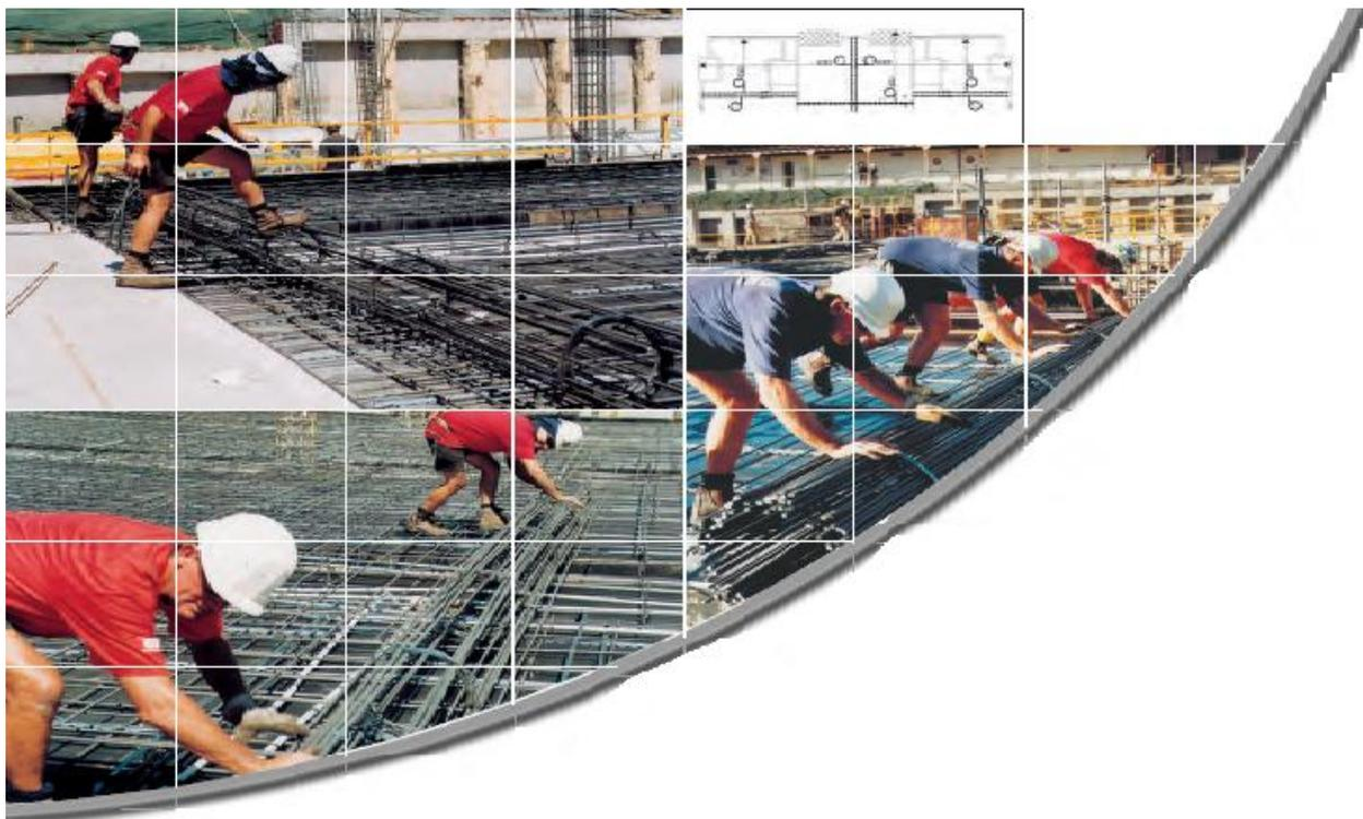
Figura 2.27 - Aplicação de produtos pré-fabricados – tapetes de aço (ONE STEEL, 2007)
