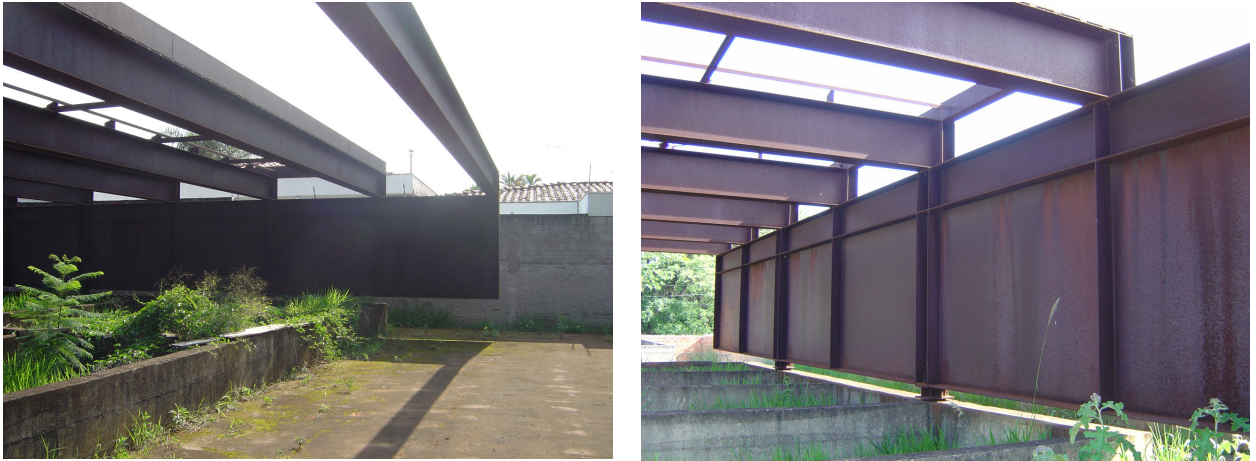
Figura 4.52. – Projeções em balanço da estrutura metálica Fotos: o autor
