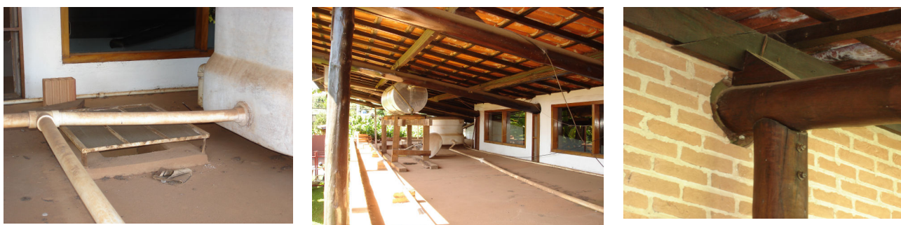
Figura 4.33. – Pavimento técnico – janelas do lavabo e estar e anel de vedação – res. Wilson Cano Fotos: o autor
