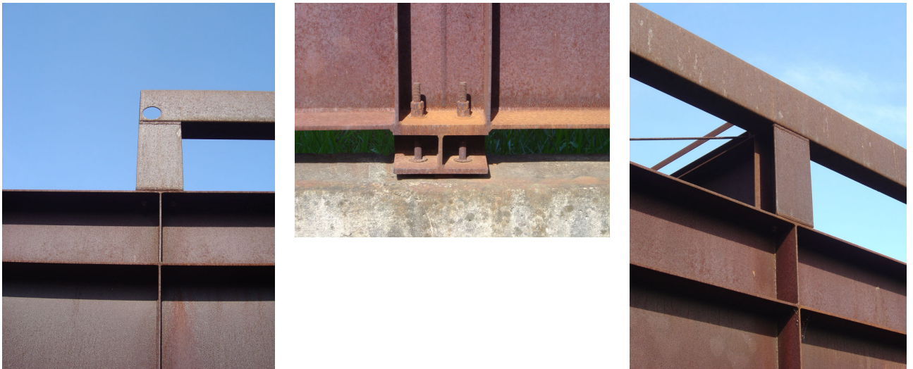
Figura 4.53. – Detalhes da estrutura metálica Fotos: o autor
