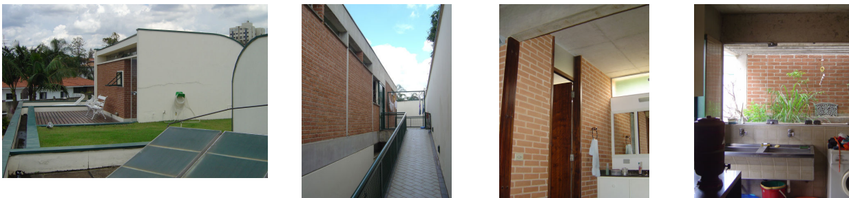
Figura 4.13. – Estúdio, rampa, banheiro e lavatório e serviços – res. Paulo de Tarso B. Duarte Fotos: o autor
