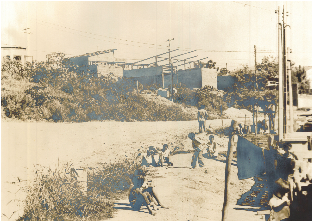
Figura 4.4. – Construção do Centro Comunitário Foto: Arq. Antonio da Costa Santos, 1978 TGI Arq. Maria Luiza de Oliveira Matiello
