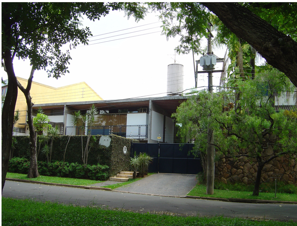
Figura 2.12. - Caixa D'água – res. Antonio Celso Rosa Foto: o autor
