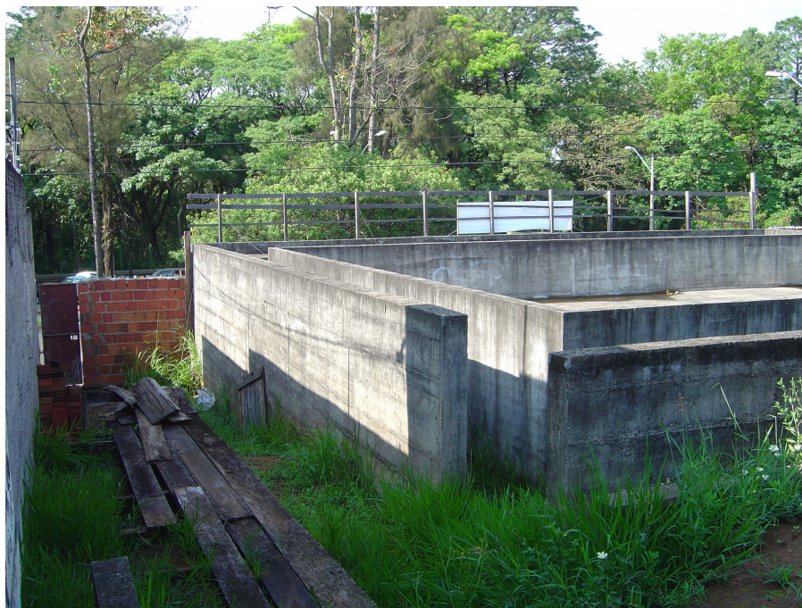
Figura 4.59. – A escada provisória – res. Paulo Roberto da Costa Santos Foto: o autor
