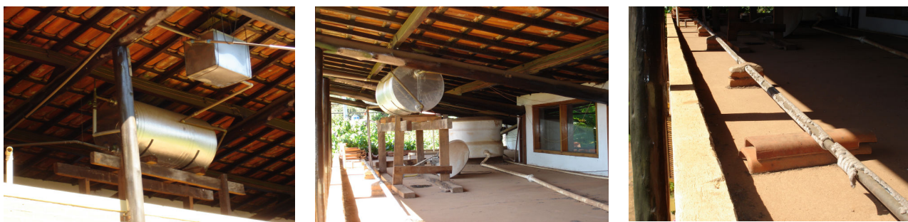
Figura 4.32. – Aspectos do pavimento técnico – rede hidráulica – res. Wilson Cano Fotos: o autor
