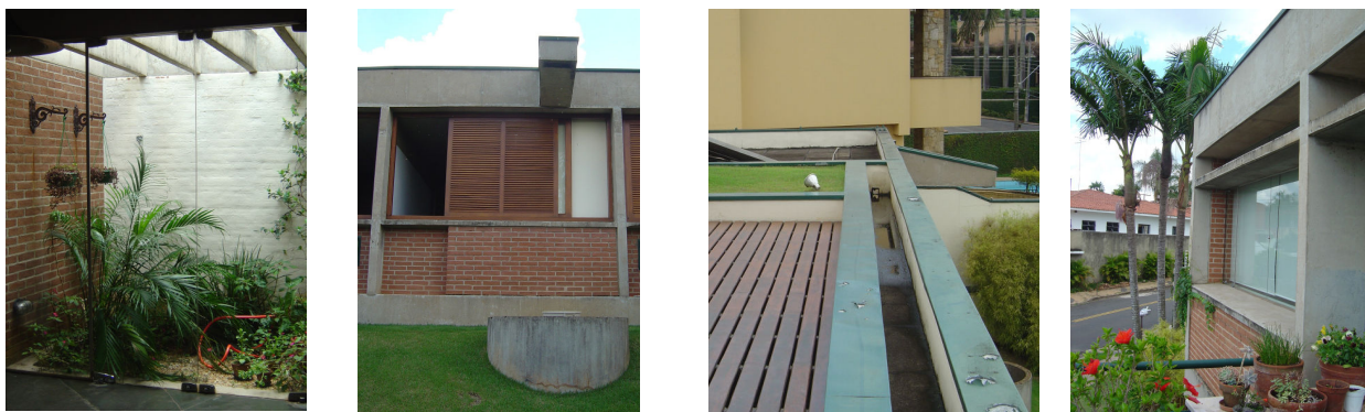
Figura 4.22. – Pérgula, gárgula e caixa de coleta, viga-calha e brise horizontal – res. Paulo de Tarso B. Duarte Fotos: o autor
