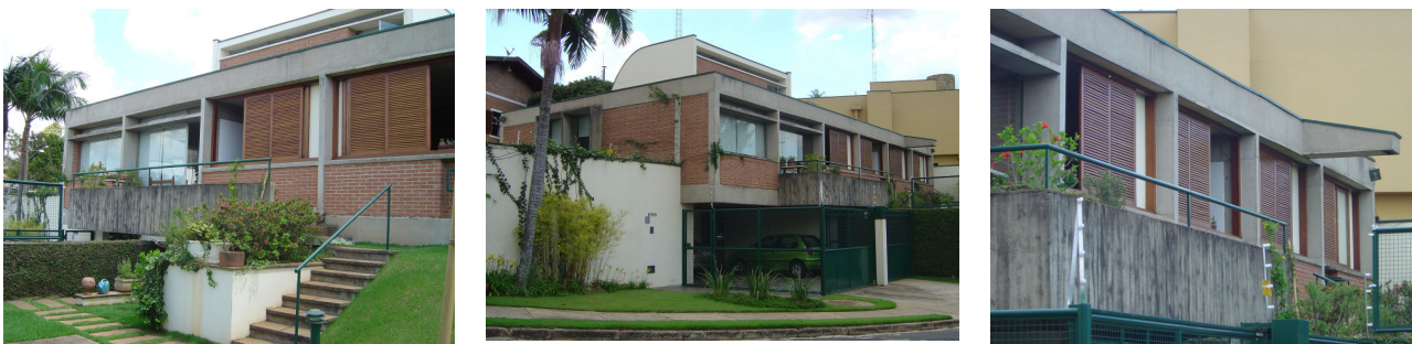
Figura 4.16. – Aspectos da residência Paulo de Tarso B. Duarte, em 2007 Fotos: o autor
