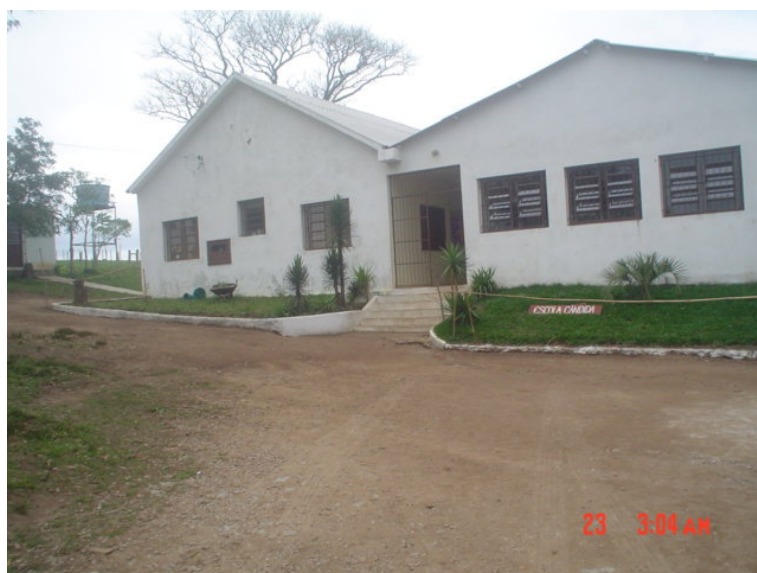
Figura 18: O prédio da escola reformado, em outubro de 2008.
