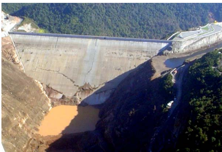
FIGURA 1.3 - Barragem da Usina Hidrelétrica de Campos Novos FONTE: MONTEIRO (2006)
