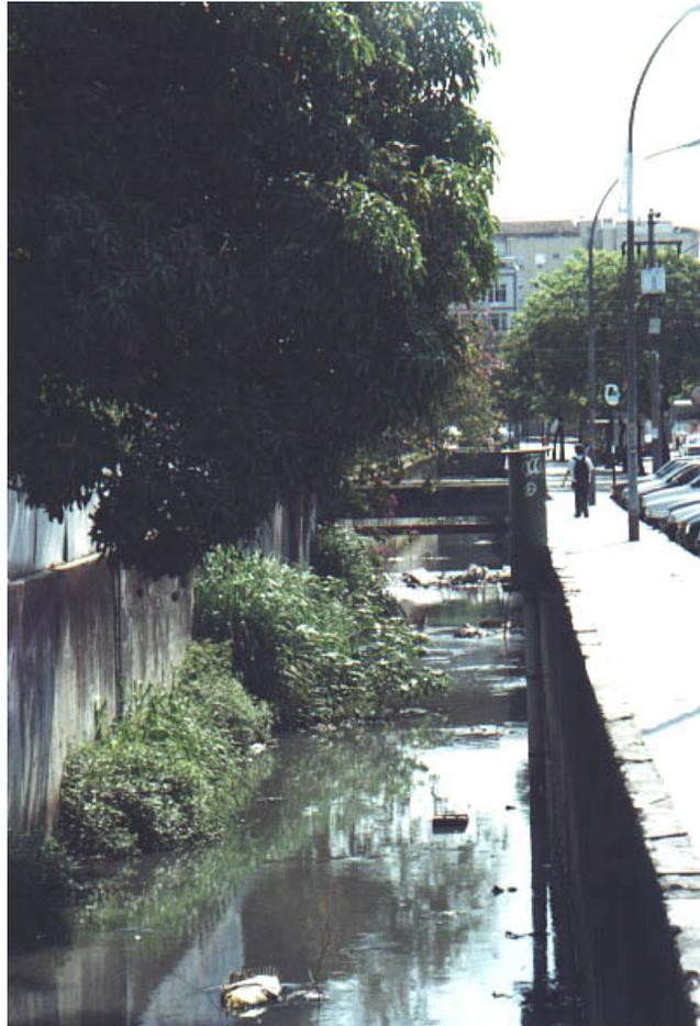
**Foto 25: Degradação do canal do Rio Trapicheiros, na rua Doutor Satamini em 2000. Vegetação crescendo no interior da calha e acúmulo de lixo. (Foto da autora, 2001)**
