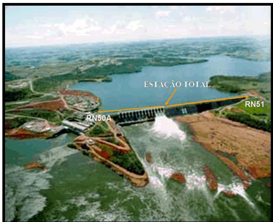
FIGURA 5.6 – RN-50A E RN-51 – BARRAGEM DE SALTO CAXIAS
