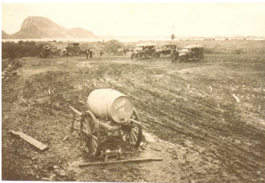
Foto 5: Fotografia onde se visualiza um aterro promovido pela administração Carlos Sampaio em 1922, com vias de urbanização da orla da Lagoa .
