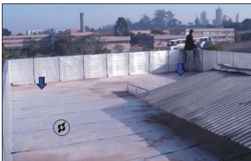
FIGURA 139–LAJE DE COBERTURA DO AUDITÓRIO
