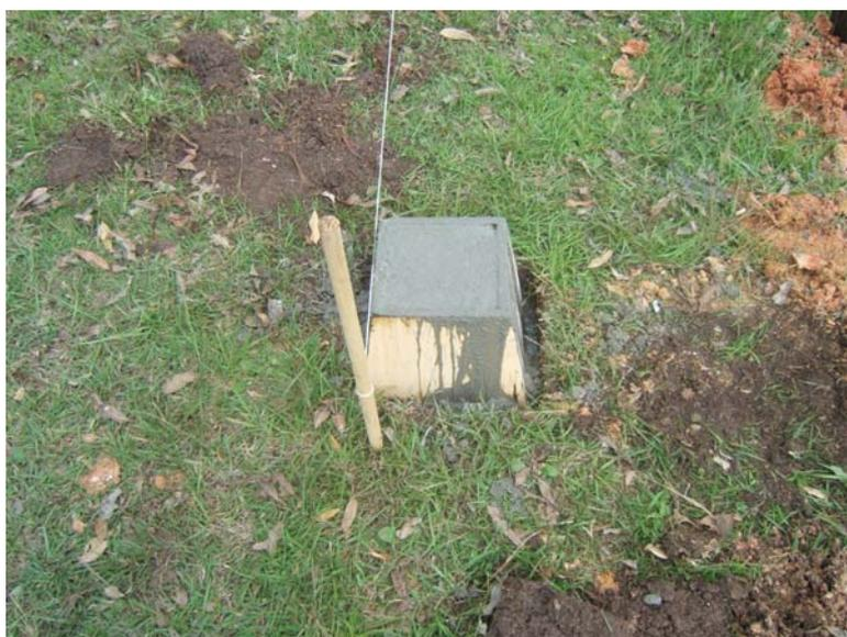
Depois, em uma RN existente, foi instalado um teodolito eletrônico (figura 4.6) e foi realizado o alinhamento dos pinos colocados no concreto ainda úmido (Figura 4.7).
