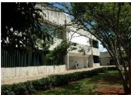
Figura 3: Prédio do CNIA
