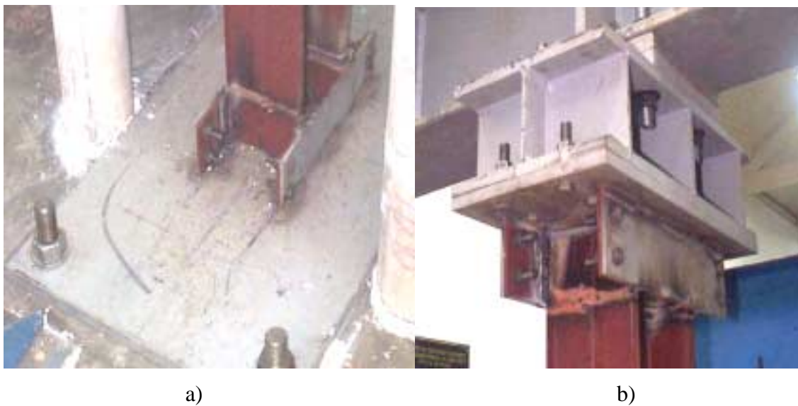
Figura 5.10 – Fotos dos sistemas de fixação do pilar P1 do Protótipo PCP1V1. a) Placa de base; b) Pilar suporte.
