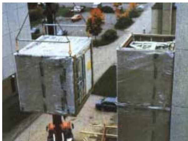
Figura 1.3 – Instalação de unidades modulares de banheiros. Fonte: Lawson, 1999.
