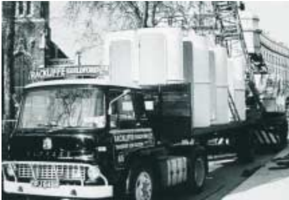
Figura 2.21 – (a) Transporte dos módulos. (b) Módulos prontos para içamento. Fonte: Amery, 2000.
