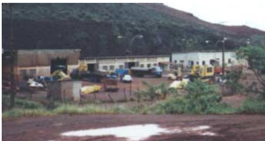
Figura 5.1 – Vista geral do almoxarifado e oficina existentes.
