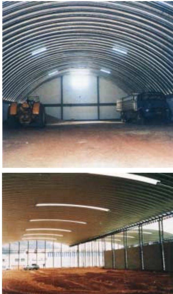
Figura 4.18 – Galpões com utilização de painéis estruturais em arco. Fonte: Imasa, 2002.
