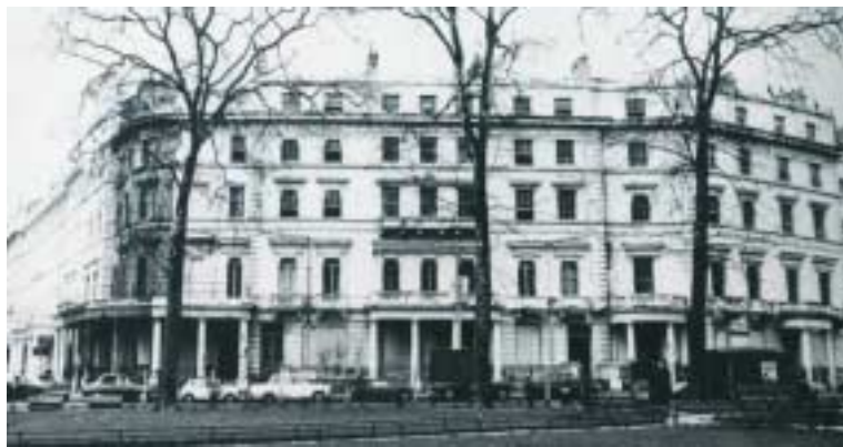
Figura 2.14 – Vista da fachada frontal da edificação. Fonte: Amery, 2000.
