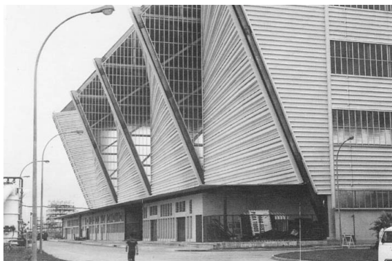
Figura 3.10 – Fachada lateral. Fonte: Dias, 1993.
