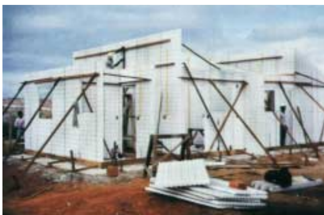
Figura 4.14 – Painéis de poliestireno expandido em execução na obra. Fonte: Mammini, 1998.
