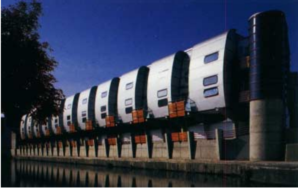
Figura 2.25 – Vista da fachada frontal da edificação. Fonte: Amery, 2000.
