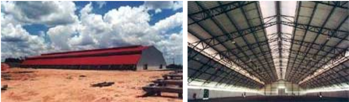
Figura 3.14 – Galpão. Fachada e vista interna.
