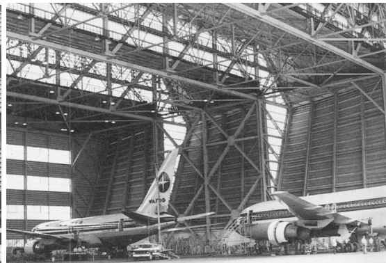
Figura 3.11 – Vista interna. Fonte: Dias, 1993.
