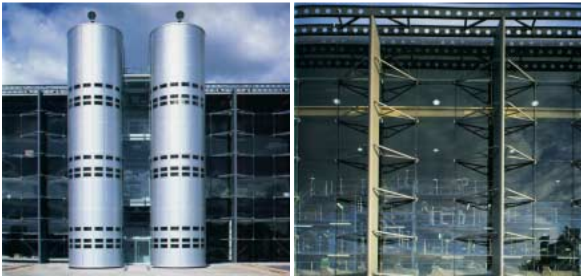
Figura 2.28– (a) Modulação dos painéis de fechamento. (b) Modulação do pano de vidro. Fonte: Amery, 2000.
