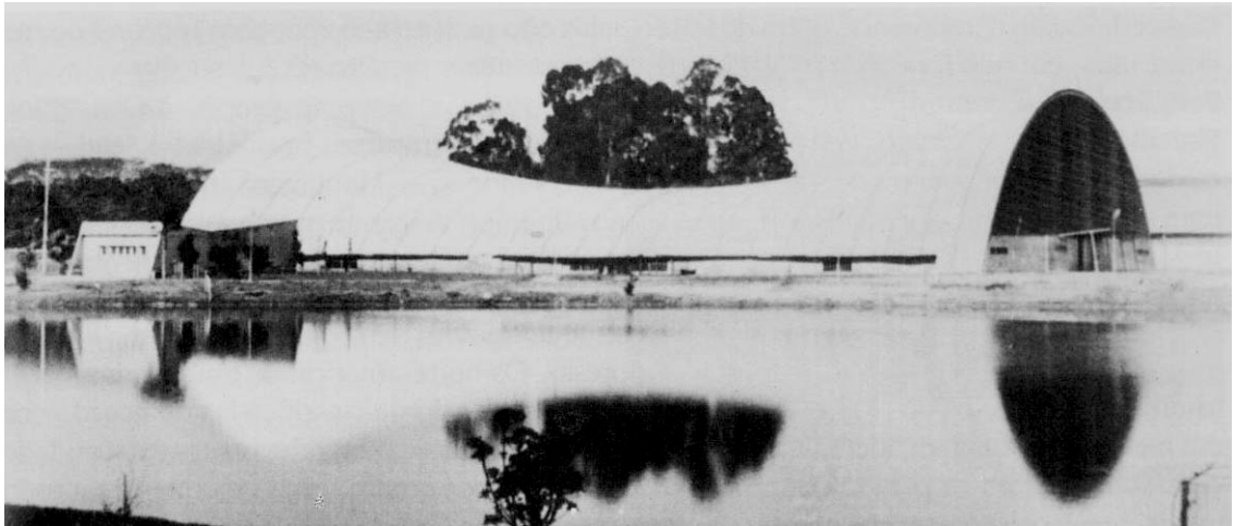
Figura 3.13 – Vista geral do Pavilhão. Fonte: Dias, 1993.
