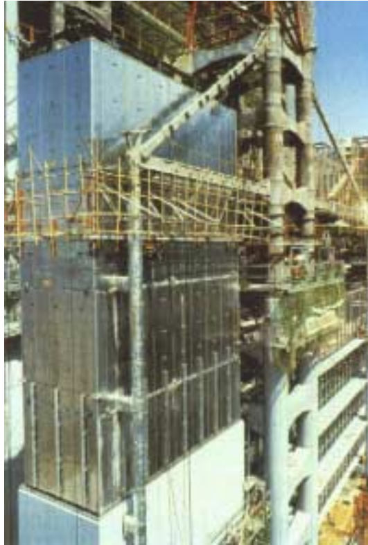
Figura 1.12 – Unidades modulares utilizadas na construção do edifício do Hong Kong Shanghai Bank , em Hong Kong. Fonte: Lawson, 1999.
