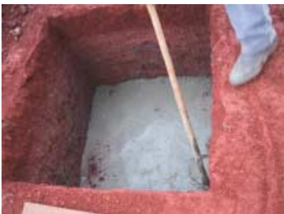
Figura 8.7 – Cava do bloco de fundação.
