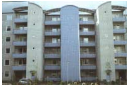
Figura 1.14 – Edifício já com a fachada acabada em Forssa, Finlândia. Fonte: Lawson. 1999.
