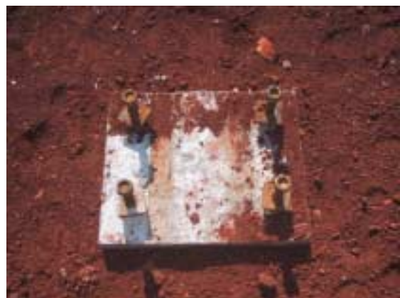
Figura 8.8 – Fundação acabada com chumbadores.
