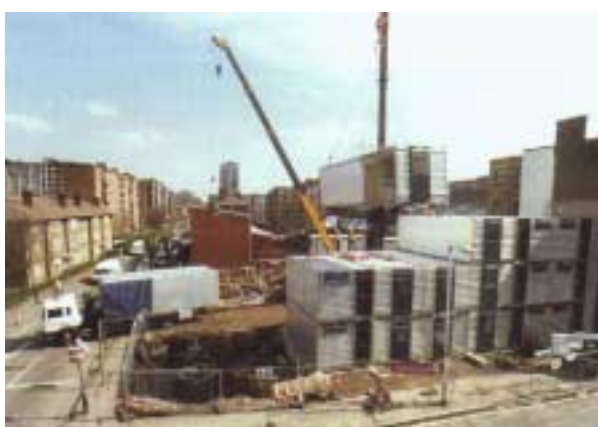
Figura 1.5 – Instalação de módulo “Yorkon” . Fonte: Lawson, 1999.
