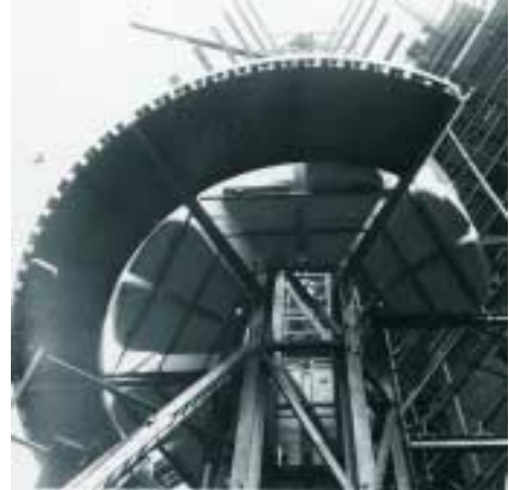
Figura 2.20 – Vista da edificação em construção. Fonte: Amery, 2000.
