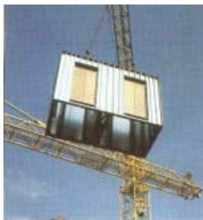
Figura 1.9 – Unidades modulares para caixa de elevadores– Schindler. Fonte: Lawson, 1999.
