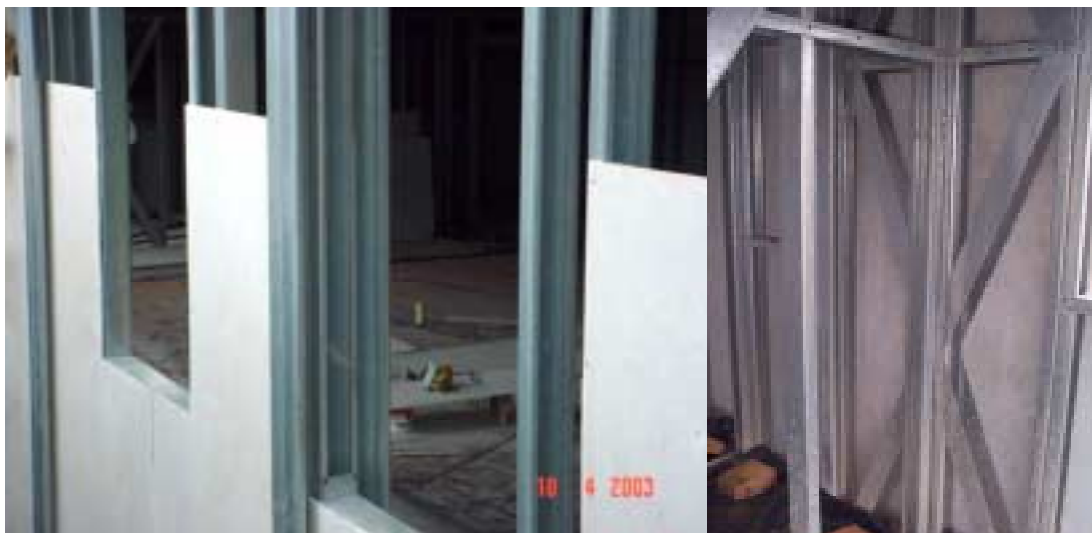
FIG. 2.25 - Vistas externa e interna de Steel-Frame com placas cimentícias
