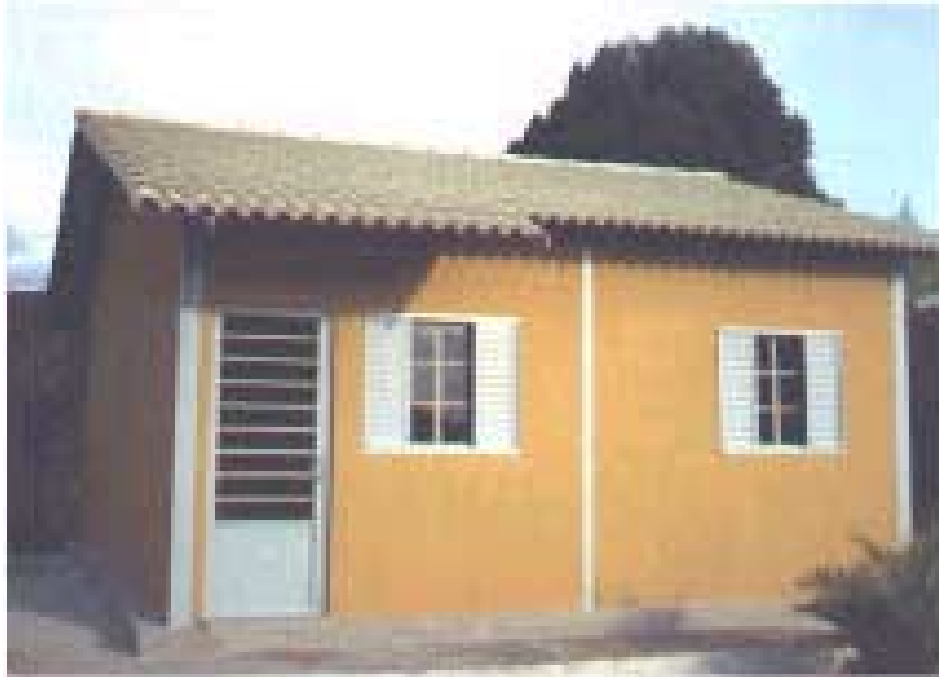
FIG. 2.20 – Habitação com placa padrão de CCA (Fonte : SICAL, 2002)
