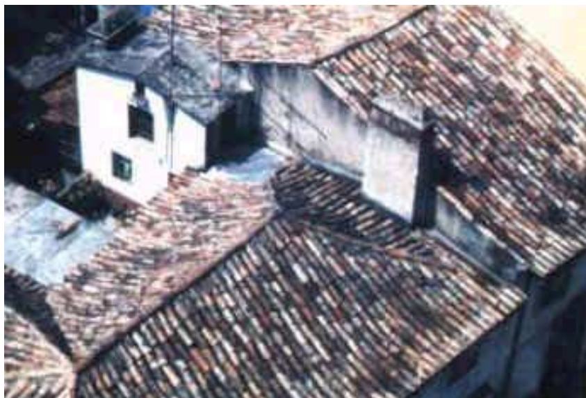
FIG. 2.29 - Telhado colonial português (Fonte: UTL, 2002)
