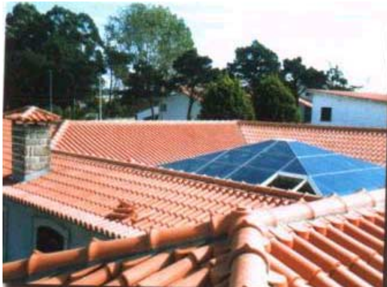
FIG. 2.31 – Telhado com telha Lusa (Fonte: UTL, 2002)
