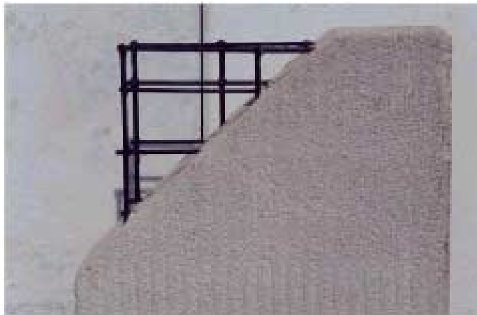
FIG. 2.13 – Painel seccionado de CCA (Fonte: SICAL, 2002)
