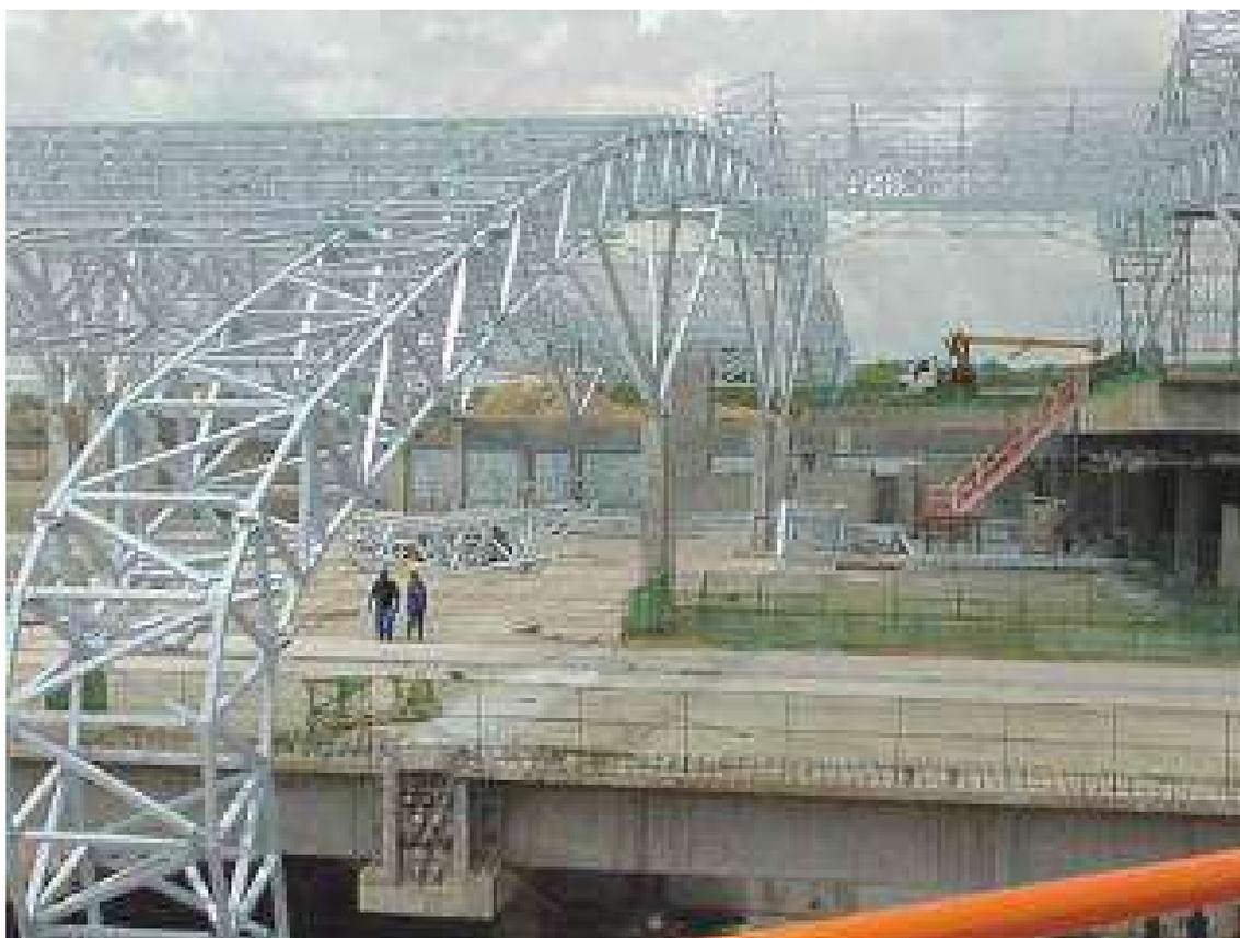
FIGURA 6.101 - Terminal de passageiros: estrutura em arco “achatado”
