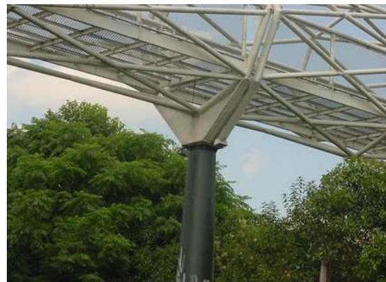
FIGURA 6.38 - Passarela: detalhes das juntas de dilatação e pilar de apoio
