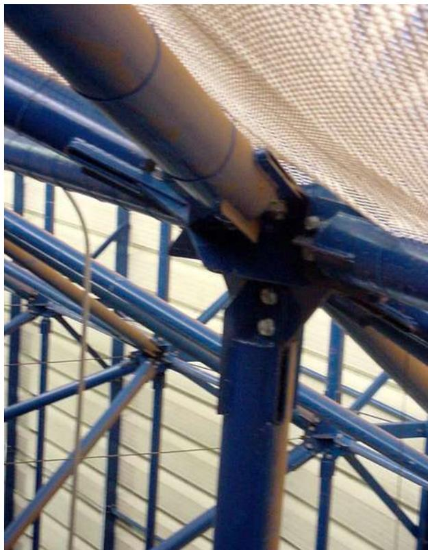
FIGURA 6.4 - Detalhes dos nós de ligação das treliças
