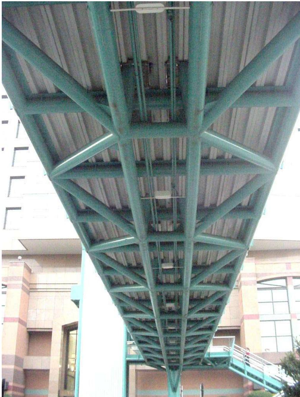
FIGURA 6.75 - Composição estrutural de suporte da passarela e tabuleiro
