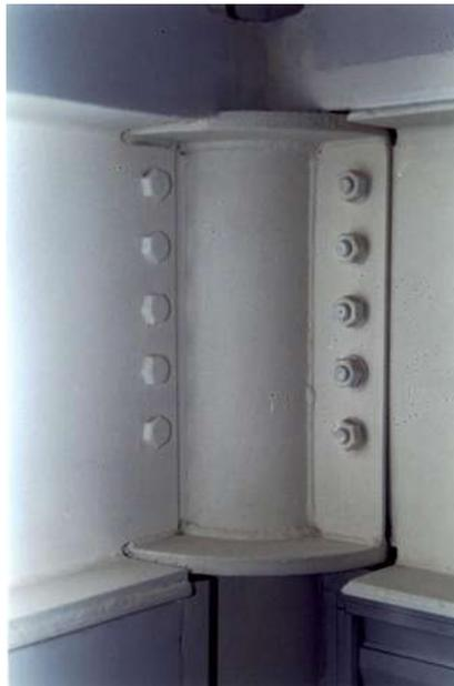
FIGURA 6.56 - Detalhe de anel de ligação e vigas tipo “I” e pilares tubulares
