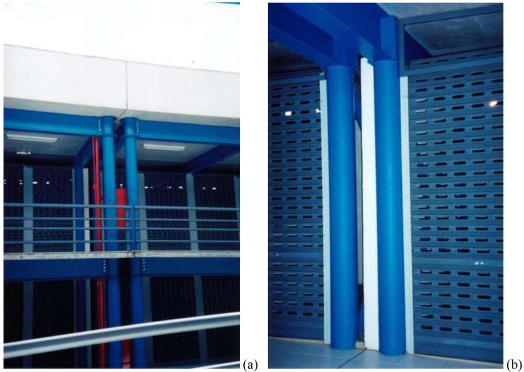
FIGURA 6.92 - Vista das juntas de dilatação: (a) juntas de dilatação nos pavimentos; (b) detalhe de junta de dilatação entre lojas
