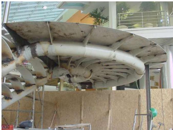
FIGURA 6.41 - Detalhe escada em perfil tubular calandrado
