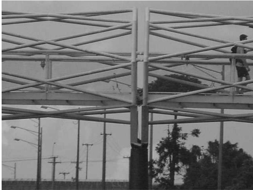
FIGURA 6.36 - Malha da passarela e detalhe da junta de dilatação
