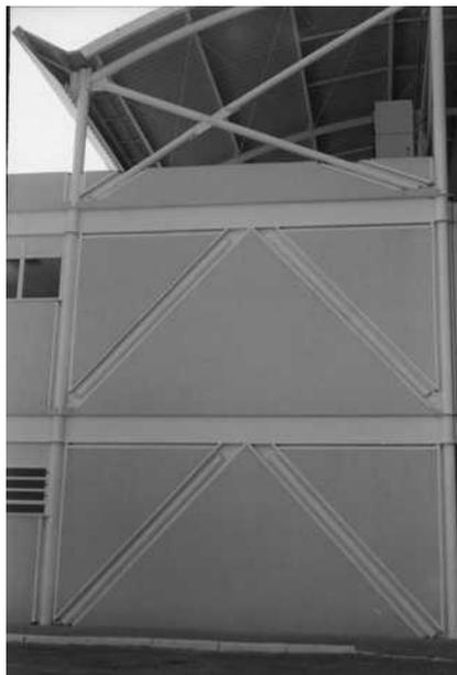
FIGURA 6.57 - Contraventamentos em “K”, em “X” e vigas tipo “I”
