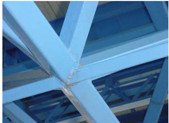
FIGURA 6.32 - Detalhes dos diversos tubos usados na composição da cobertura
