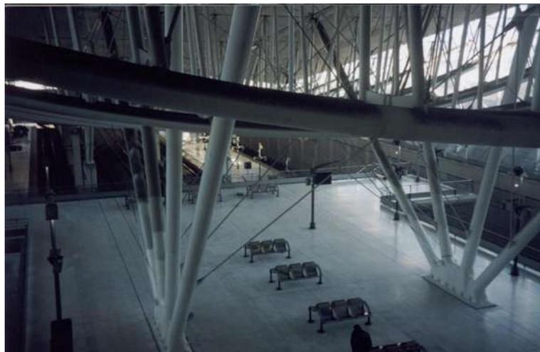
FIGURA 3.24 - Sistema estrutural em perfis tubulares em leque e
