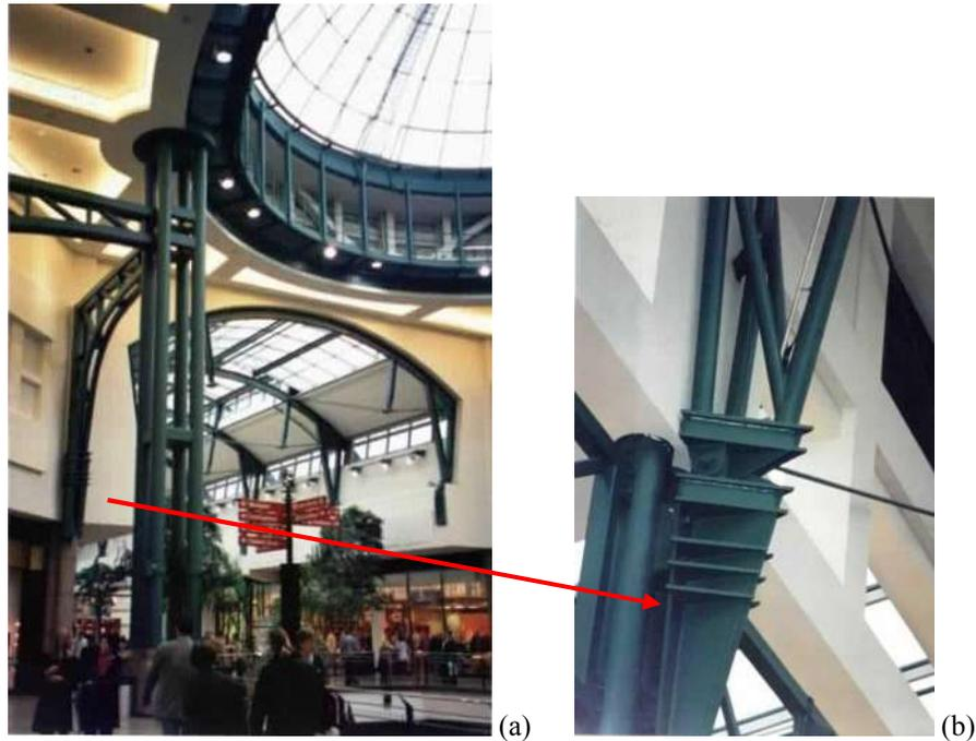
FIGURA 3.40 - Shopping Center Neue Mitte Oberhausen – Oberhausen, Alemanha. Composição de pilar: (a) mão francesa associada ao pilar principal; (b) detalhe do arremate do pilar
