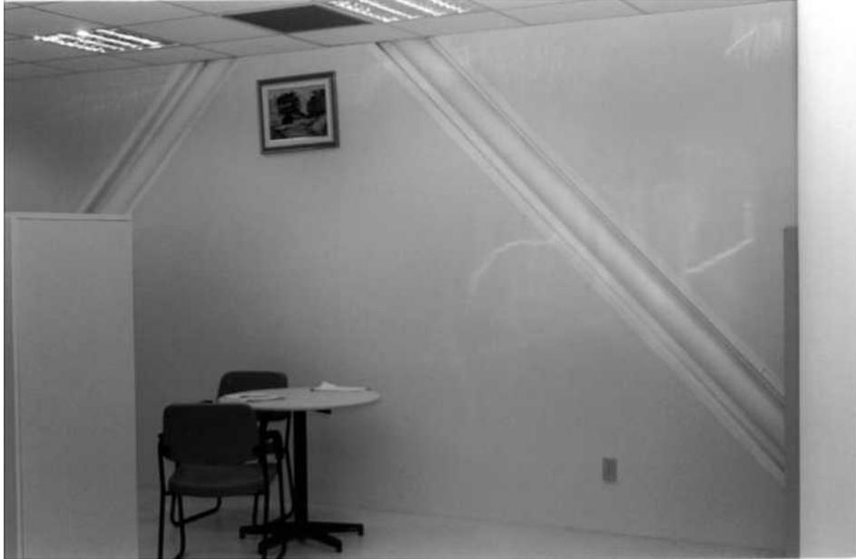
FIGURA 6.58 - Vista interna do Edifício Sede: detalhe dos contraventamentos
