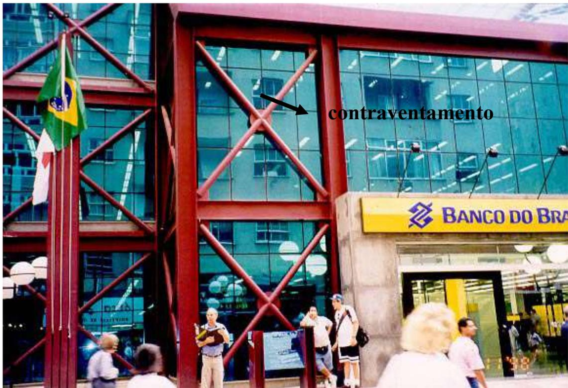
FIGURA 3.8 - Contraventamento vertical em "X"
