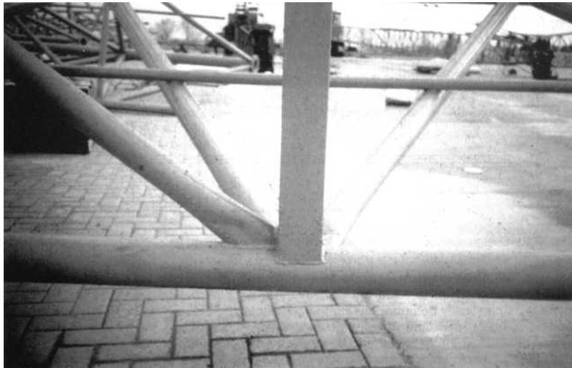
FIGURA 5.18 - Ligação soldada com as extremidades das diagonais amassadas
