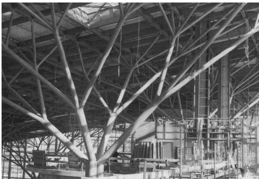
FIGURA 3.37 - Aeroporto de Stuttgart: detalhe dos pilares “árvores”
