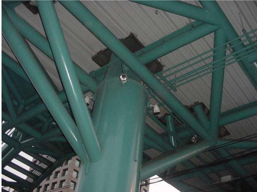
FIGURA 6.76 - Detalhe do pilar de suporte e composição estrutural
