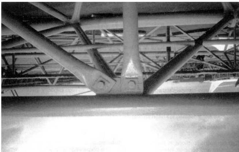
FIGURA 5.19 - Ligação parafusada (com chapa de ligação) de diagonais com pontas amassadas
