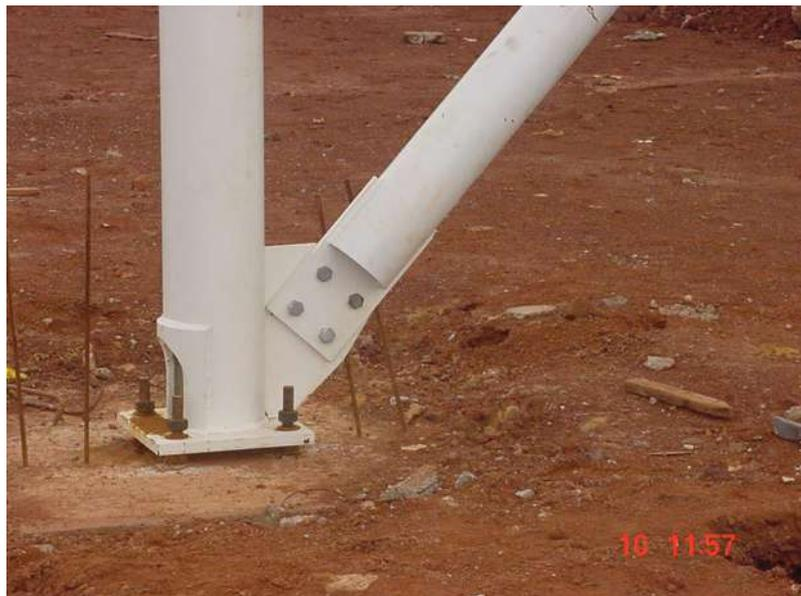
FIGURA 4.11- Ligação de tubos usando chapa de ligação
