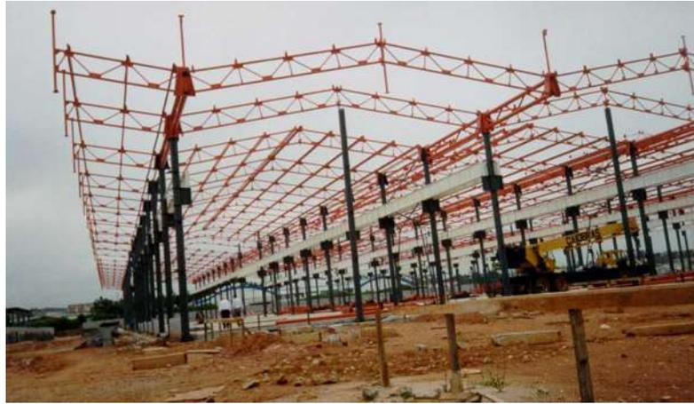
FIGURA 5.47 - Montagem de estrutura plana com auxílio de guindastes
