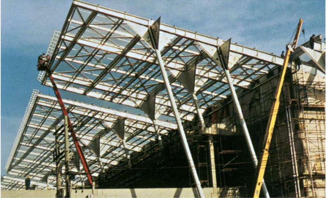
FIGURA 6.122 - Vista da montagem da estrutura
