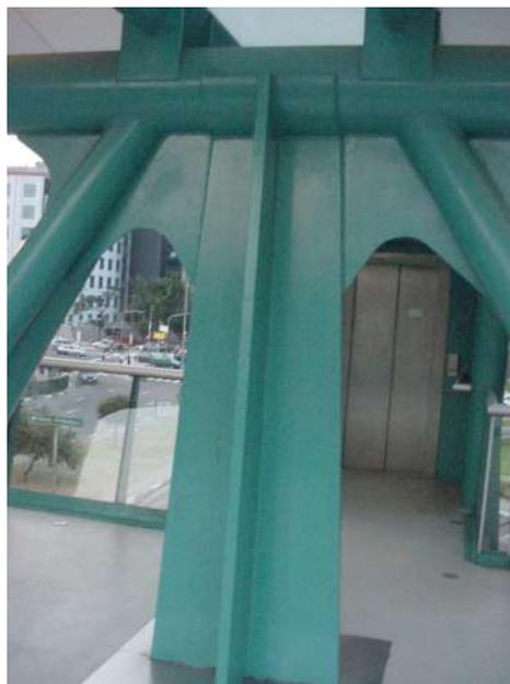
FIGURA 6.74 - Detalhe da composição de pilares estruturais internos
