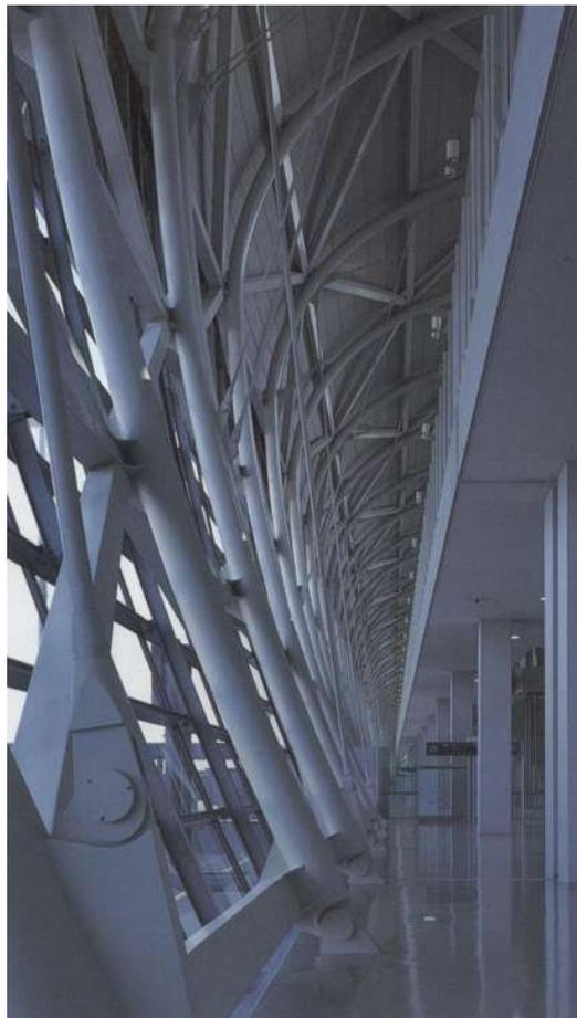
FIGURA 2.38 - Aeroporto de Kansai: detalhe do sistema estrutural de fechamento vertical (laterais)
