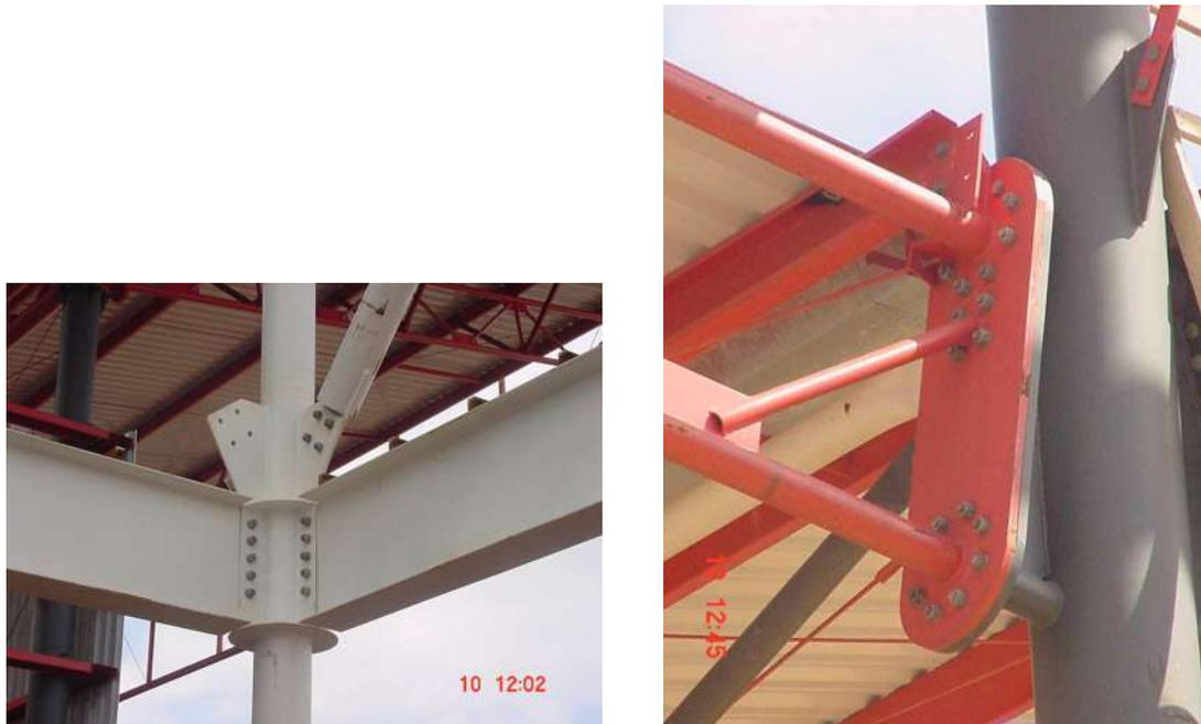
FIGURA 5.34 - Ligações com utilização de parafusos do tipo ASTM A307, A325 ou A490
