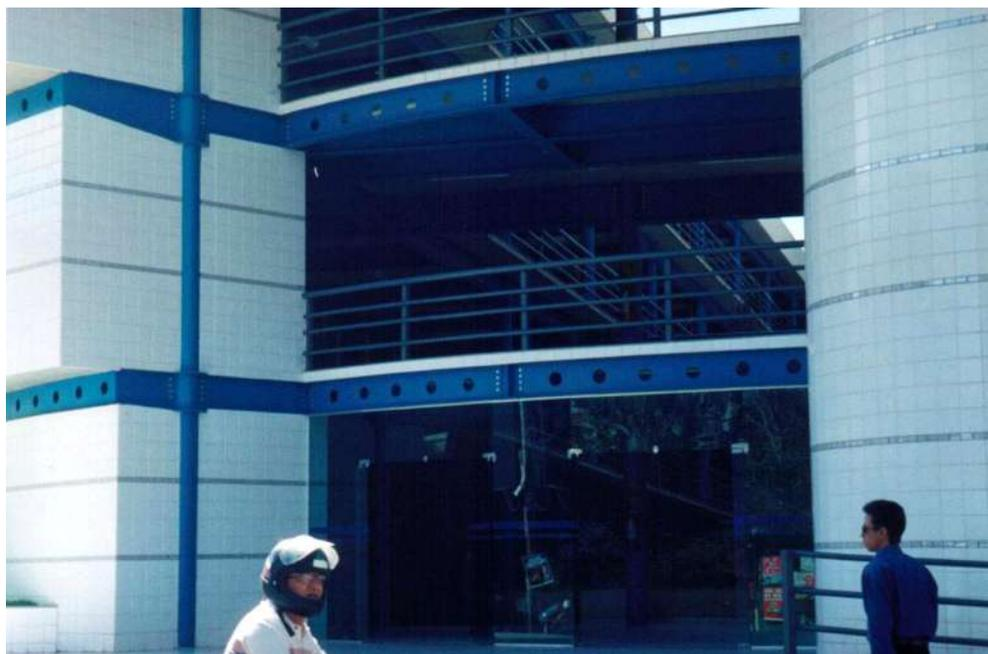
FIGURA 6.93 - Entrada principal: detalhe das vigas calandradas com recorte na alma
