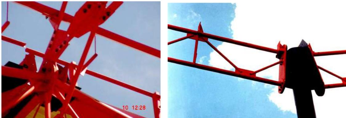
FIGURA 5.48 - Detalhe de ligação das tesouras do arco e da tesoura do galpão com as colunas
