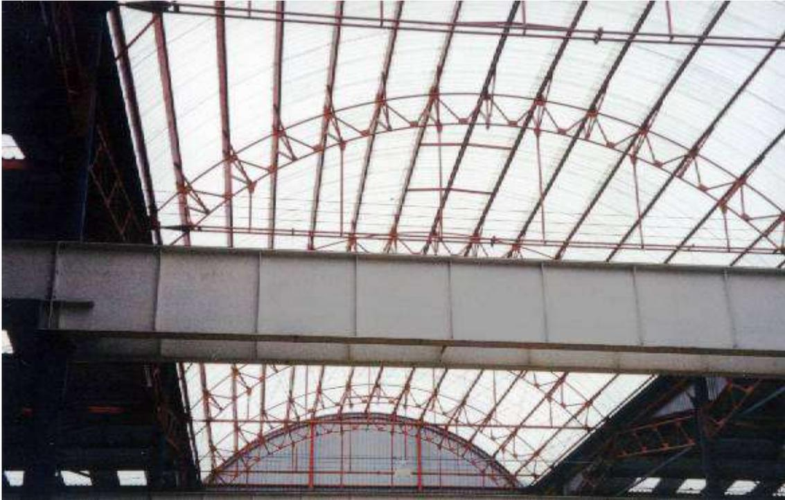
FIGURA 6.61 - Galpão: detalhe da cobertura - parte curva elevada translúcida
