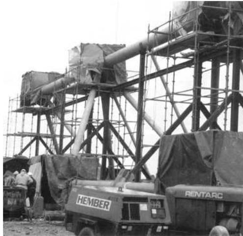
FIGURA 5.45 - Soldagem no canteiro com a utilização de proteção contra intempéries
