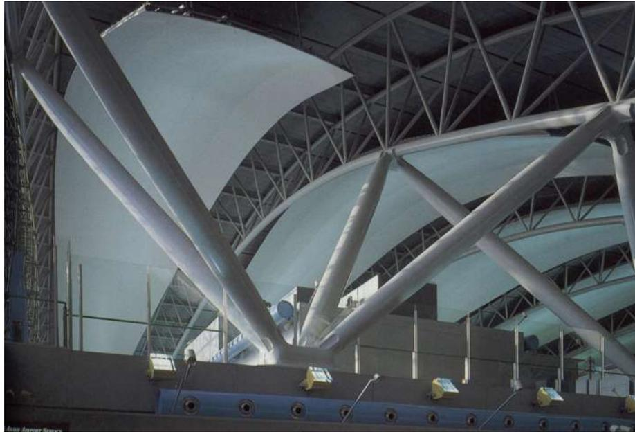
FIGURA 2.41- Aeroporto de Kansai: detalhe dos pilares da cobertura e do sistema treliçado
