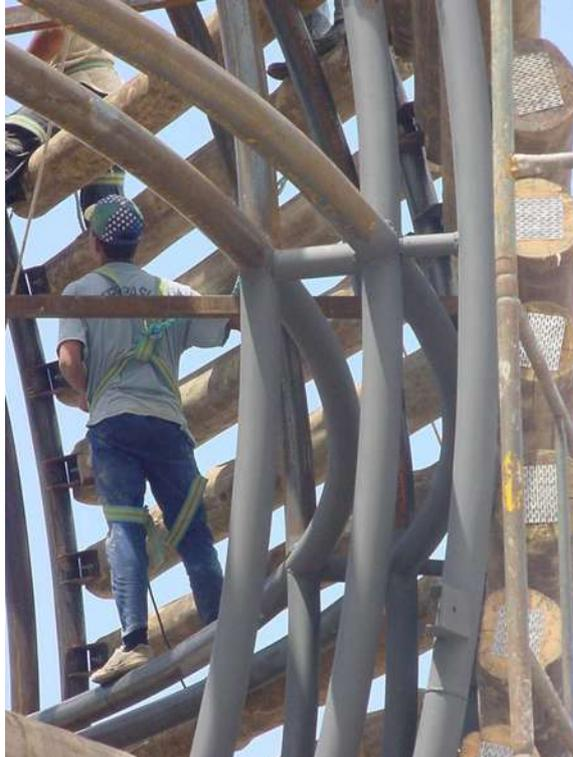
FIGURA 6.45 - Esfera: detalhe da estrutura em perfis tubulares e toras de madeira (revestimento – fechamento)
