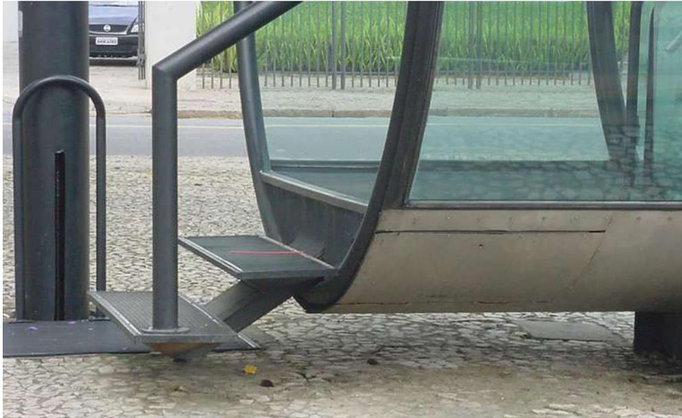
FIGURA 6.26 - Detalhe do piso elevado nas plataformas de embarque e desembarque
