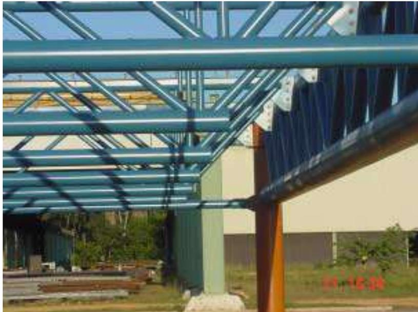
FIGURA 4.36 - Contenção por meio de vigas transversais
