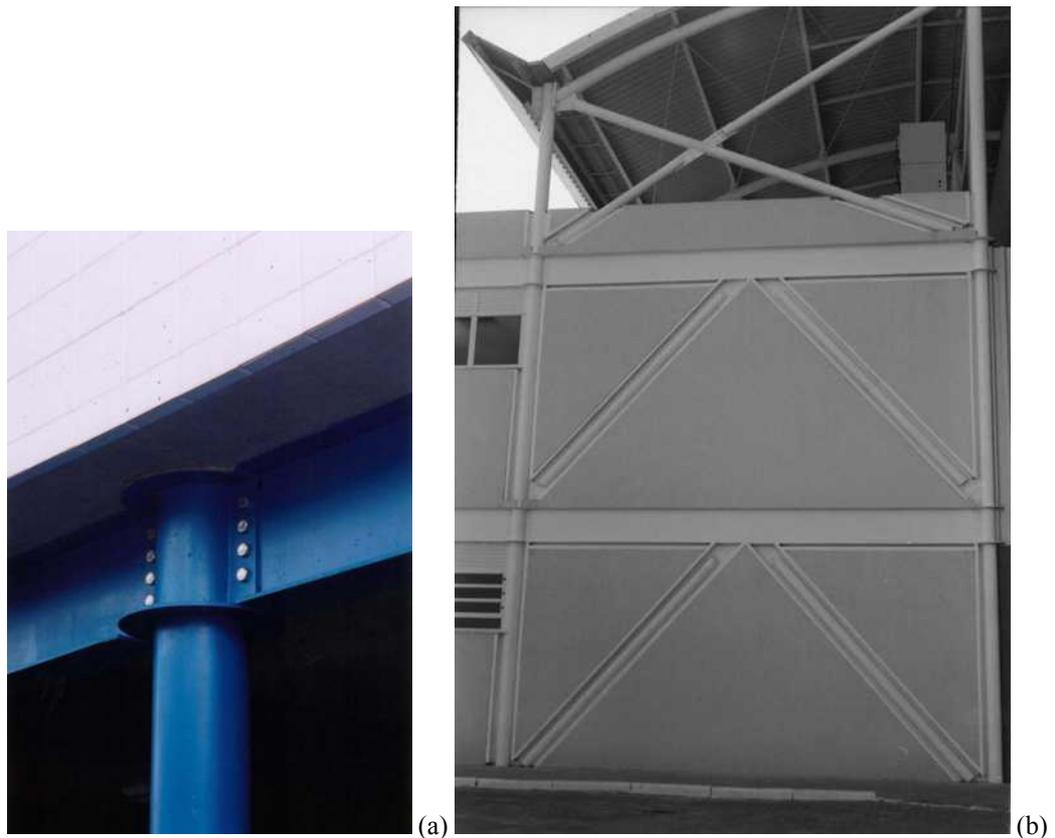
FIGURA 3.12 - Perfis tubulares submetidos a compressão: (a) pilar; (b) barra de contraventamento em “K”
