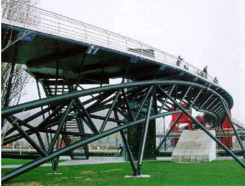
FIGURA 3.21 - Passarela com sistema estrutural em treliça espacial
