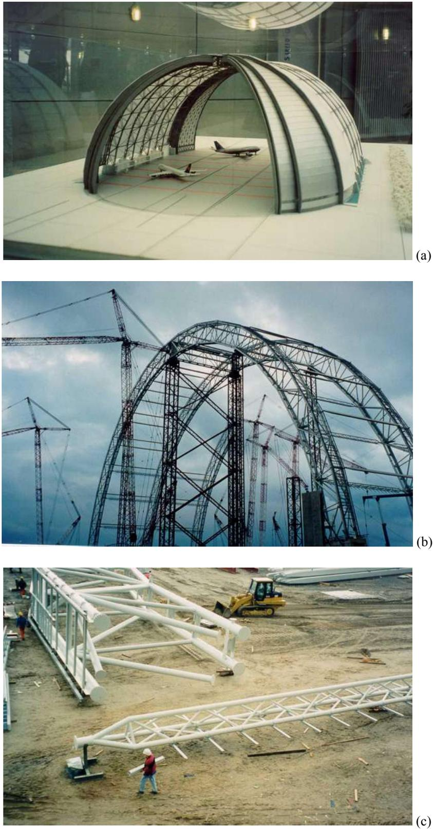
FIGURA 3.50 - Hangar Cargo Lifter. Associação de perfis tubulares em tenso-estruturas: (a) maquete; (b) montagem da estrutura principal; (c) vista de vigas treliçadas no solo
