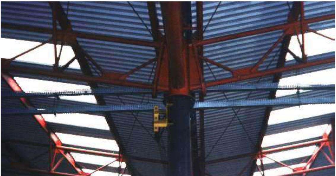
FIGURA 6.62 - Galpão: cobertura - detalhe da iluminação zenital (vários pontos) com telhas translúcidas
