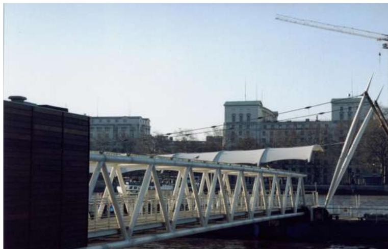
FIGURA 3.25 - Passarela em viga treliçada
