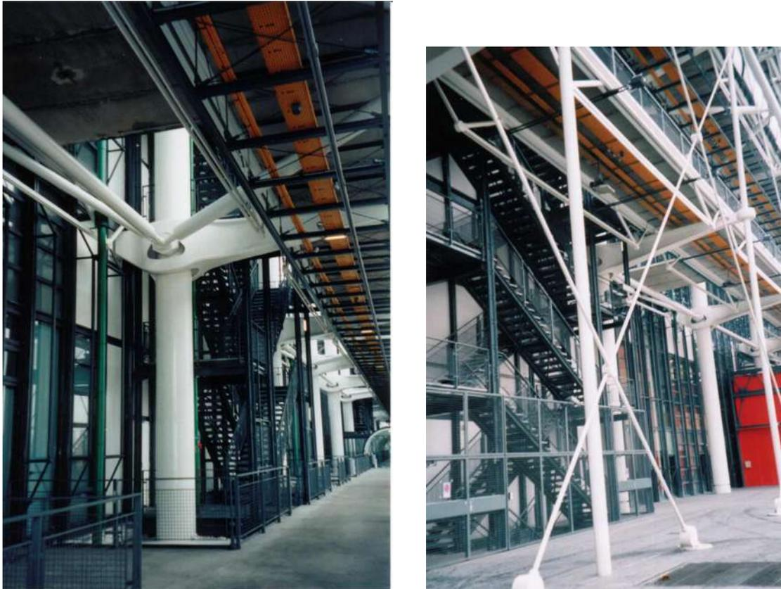
FIGURA 2.34 - Centre Georges Pompidou: detalhes estruturais – pilares e contraventamentos
