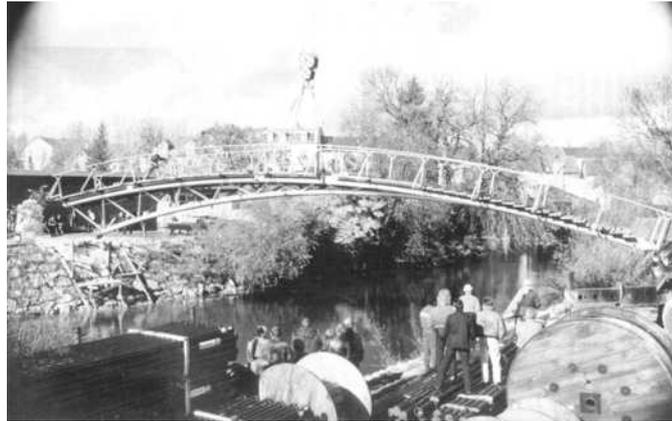
FIGURA 5.49 - Montagem de uma ponte treliçada em arco
