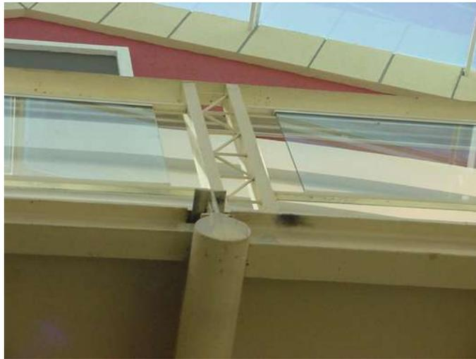
FIGURA 6.40 - Detalhe de perfil tubular como parte de estrutura de sustentação de piso
