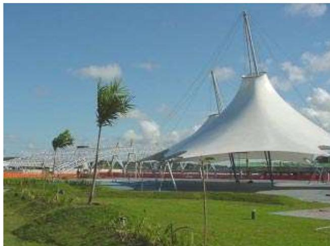
FIGURA 6.114 - Edifício Garagem: tenso-estruturas no último pavimento
