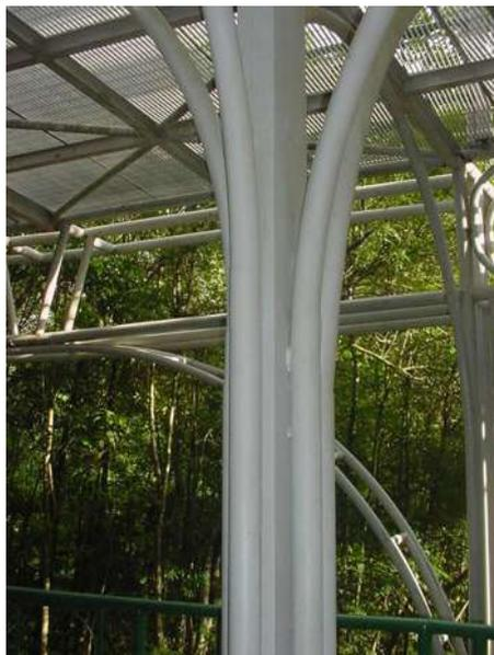
FIGURA 6.16 - Detalhe da composição do pilar
