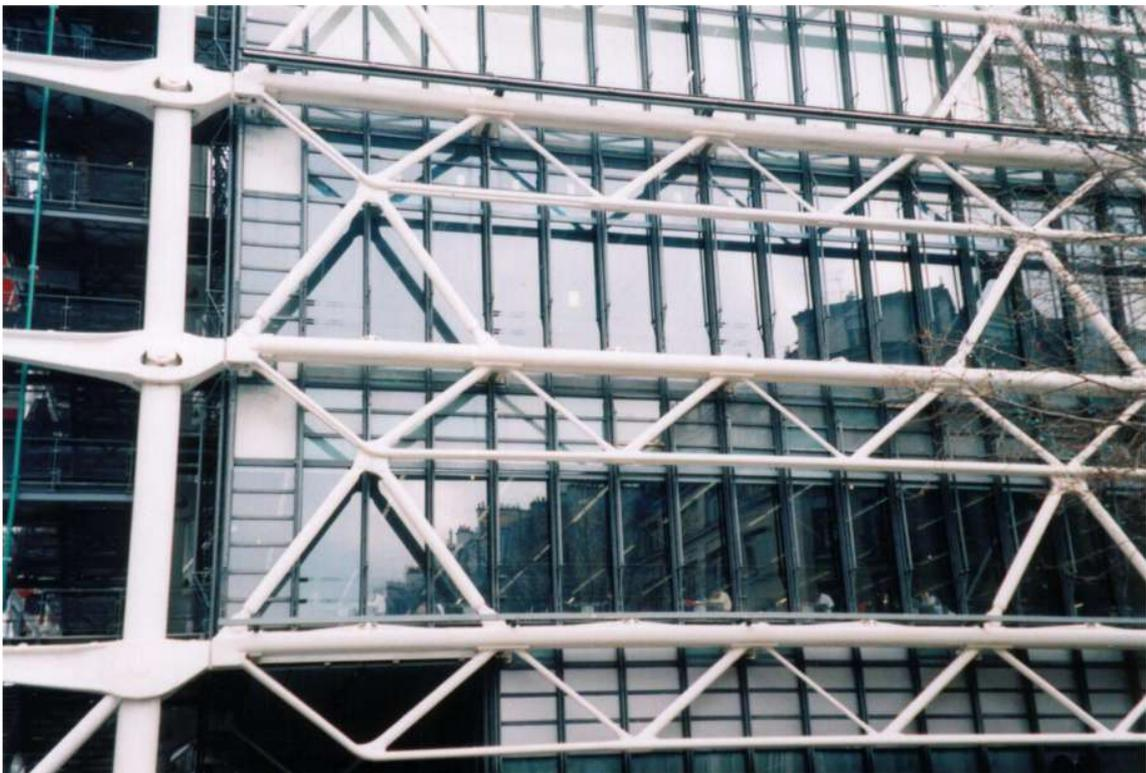
FIGURA 2.33 - Centre Georges Pompidou: detalhe de composição de treliças
