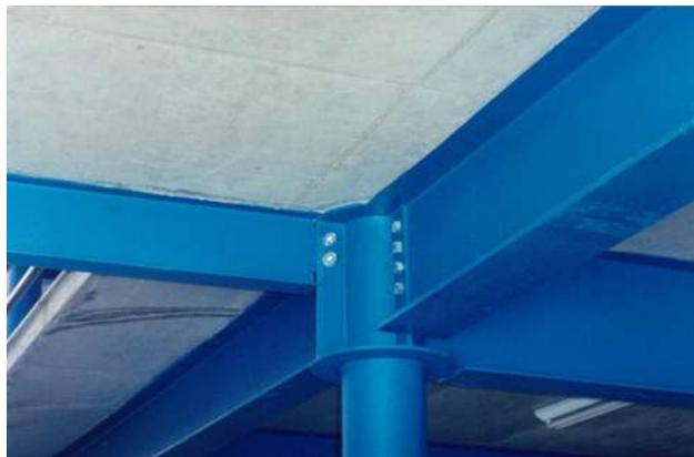
FIGURA 6.94 - Detalhe de pilar com anel de encaixe e vigas em “I” aparafusadas
