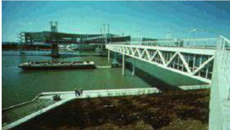
FIGURA 3.23 - Passarela em viga treliçada
