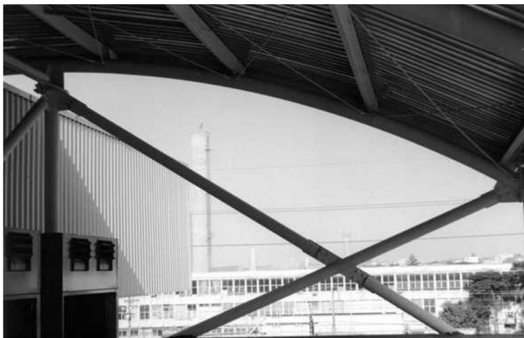
FIGURA 6.65 - Detalhe de contraventamento em “X” e elemento de cobertura curvo
