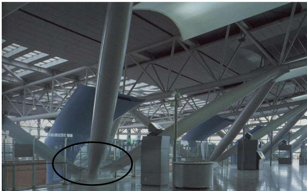
FIGURA 2.40 - Aeroporto de Kansai: detalhe da placa de base do pilar
