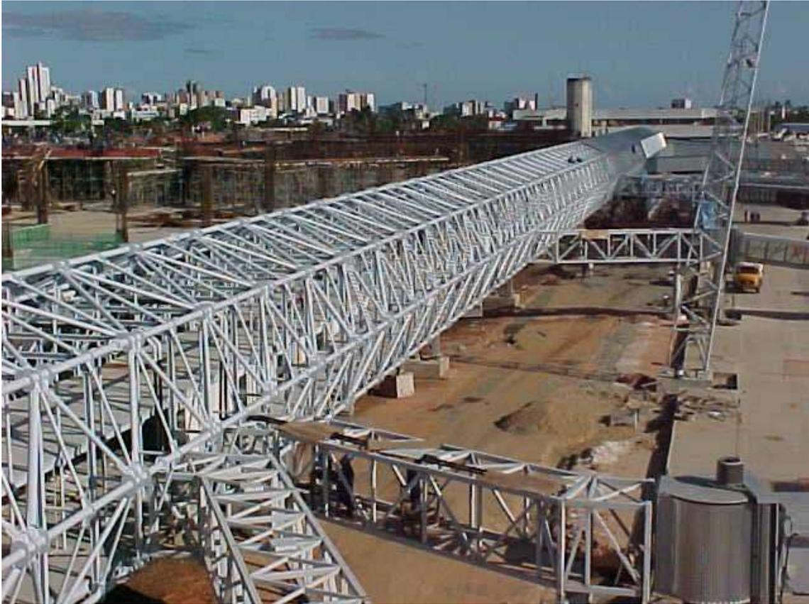
FIGURA 6.106 - Montagem do conector e pontes de embarque
