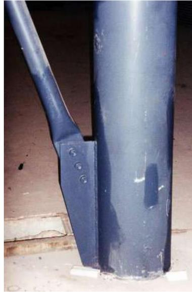
FIGURA 4.10 - Ligação de tubos com ponta amassada
