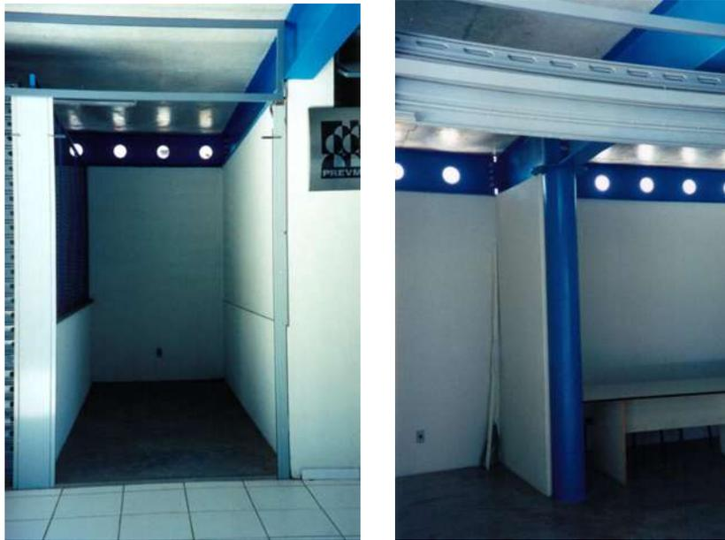
FIGURA 6.88 - Vista interior das lojas: vigas vazadas para exaustão
