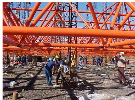
FIGURA 5.51 - Montagem de estrutura espacial acima do solo para posterior içamento
