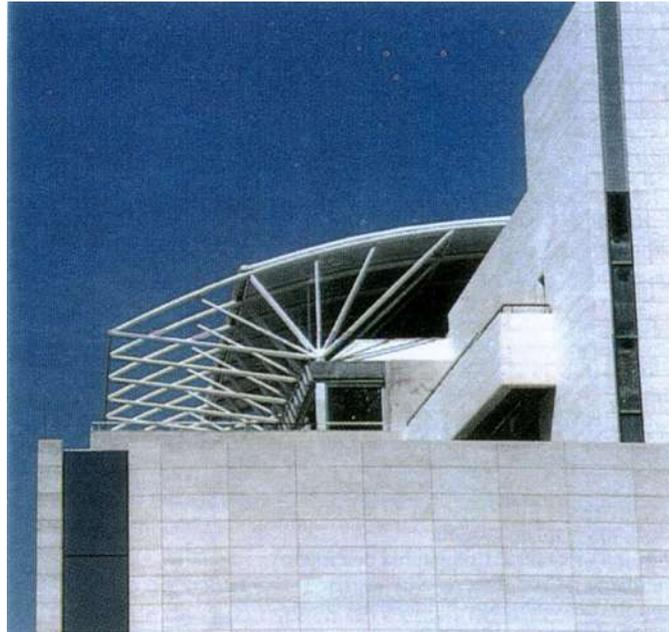
FIGURA 6.70 - Vista cobertura treliçada em estrutura metálica
