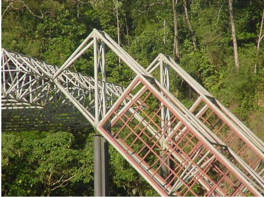
FIGURA 6.19 - Detalhe da ligação das estruturas diagonais com a treliça de cobertura
