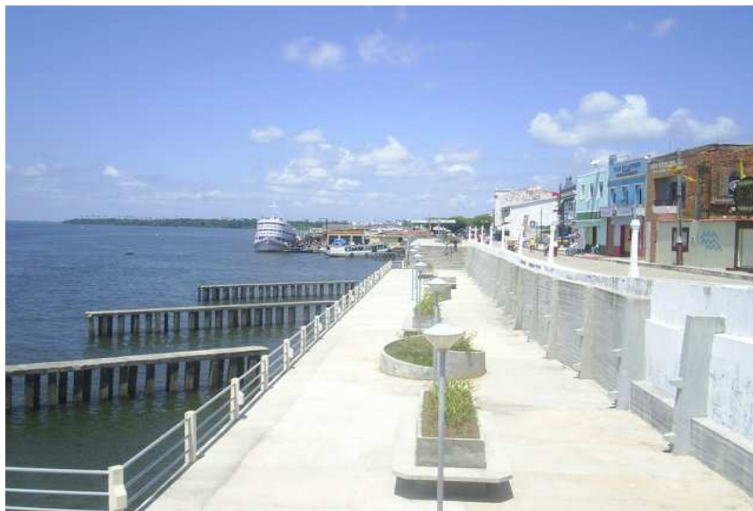
FOTO 4: ORLA DE CAMETÁ – Aspectos de revitalização da frente da cidade de Cametá, denominada de “Boulevard Romeu Peres”. (Foto: Francivaldo Foinquinos, set./2006).
