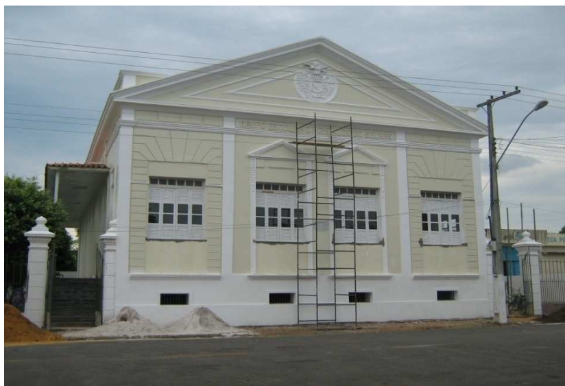
FOTO 7: ESCOLA DOM ROMUALDO DE SEIXAS – Construída em 1899, mas somente concluída e inaugurada em 1905, a edificação e utilização deste prédio no início do século XX retrata a riqueza da região amazônica que tinha sua economia baseada na exportação da borracha e do cacau. (FOTO: José Carlos, Jun./2007).
