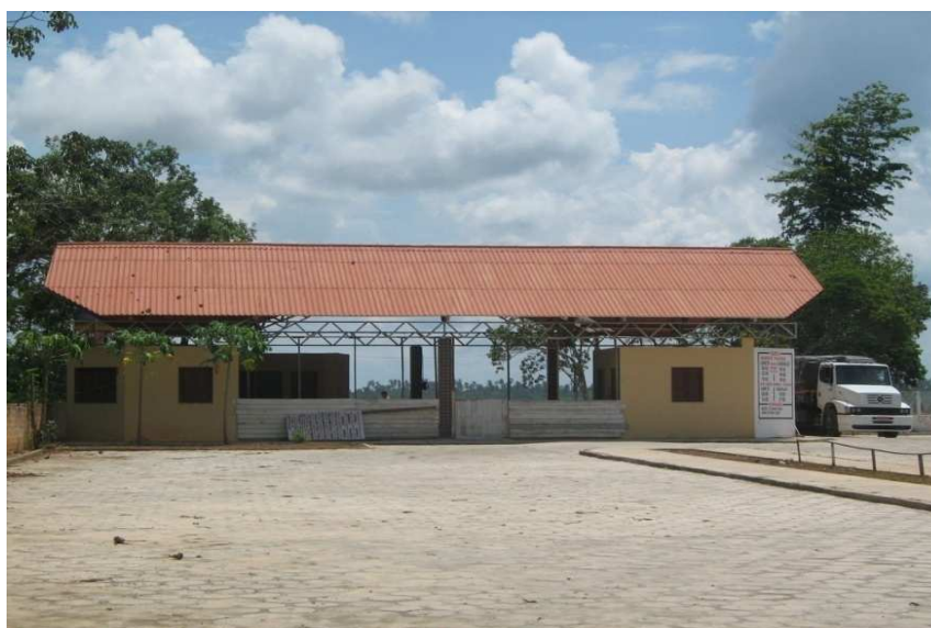
FOTO 3: TERMINAL HIDROVIÁRIO – construído no bairro da Aldeia, exemplo de intervenção urbana e elemento da infra-estrutura de apoio ao turismo no Município. (Foto: José Carlos, Jun./2007).
