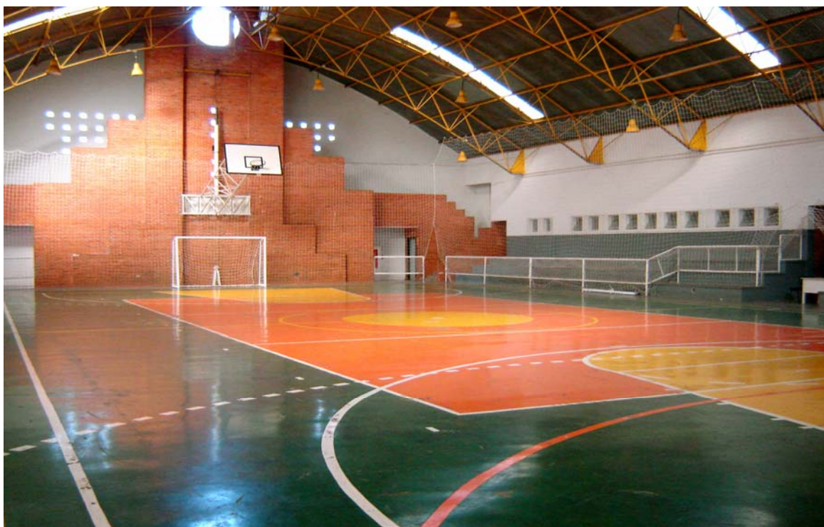
Figura 14. Vista interna da quadra de esportes coberta
