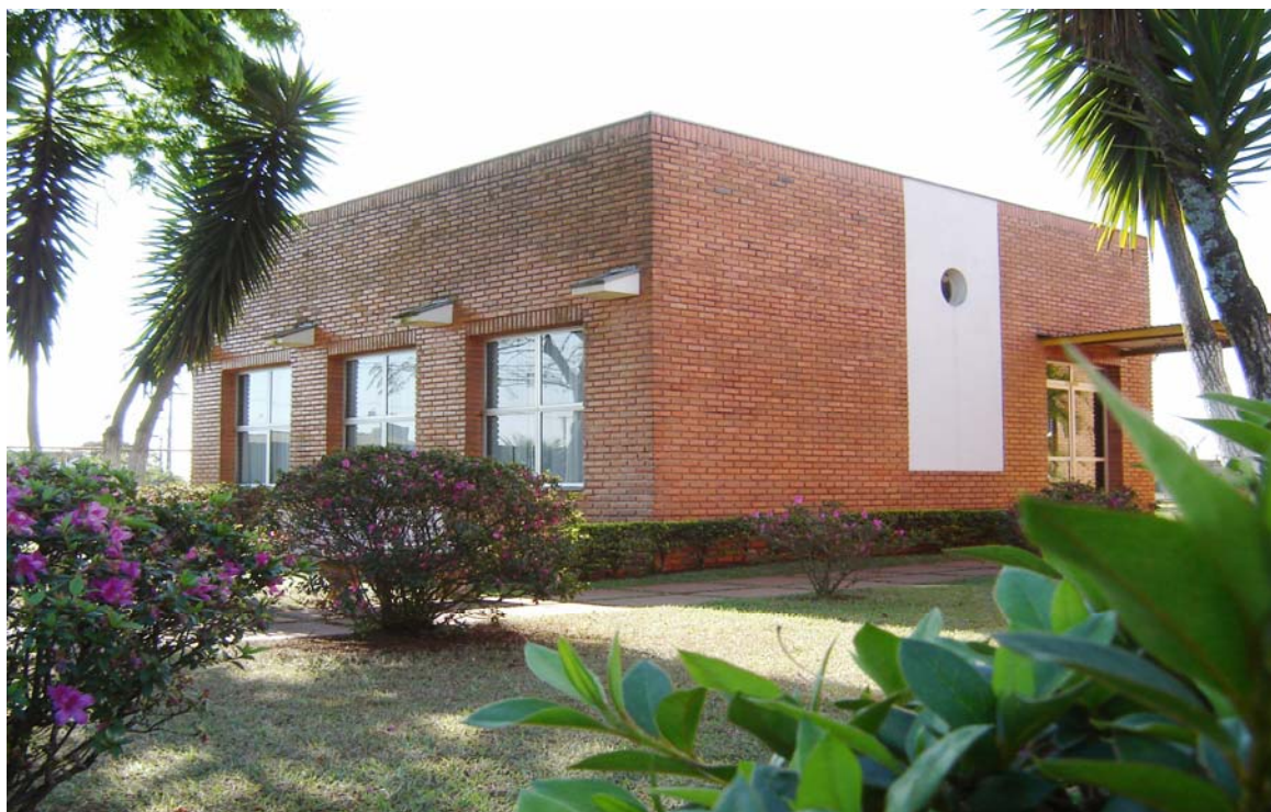
Figura 17. Vista externa do auditório
