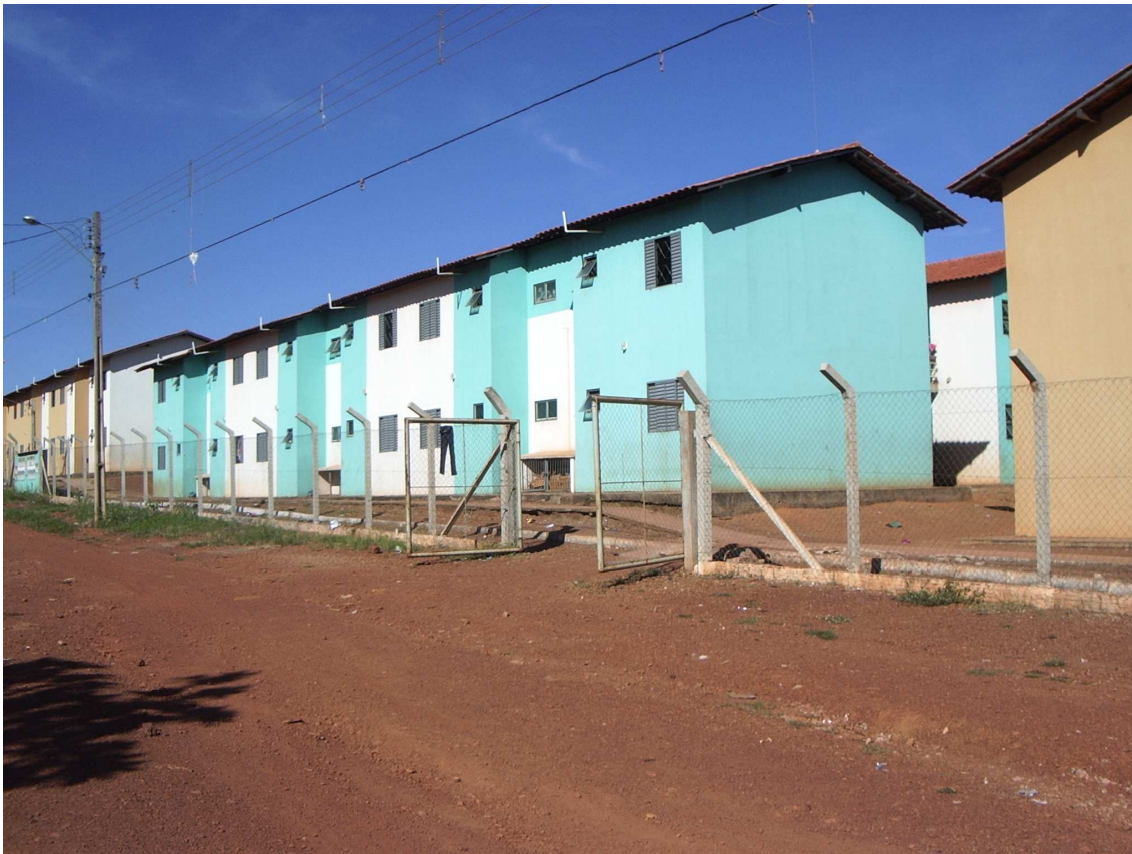
Foto 37: Residencial Vila Rica, construído no Jardim Aurenny III (Fonte: AMARAL, 2009)
