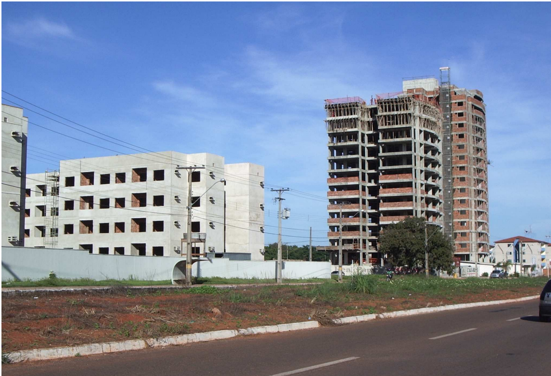
Foto 14: Edifícios em construção na ARNE 12, região central. (Fonte: AMARAL, 2009)
