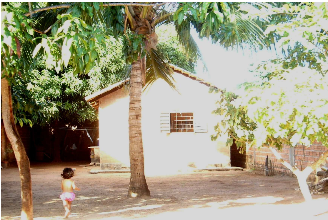
Foto 5: Casa construída na Vila União para regularização de ocupação. (AMARAL, 2009)
