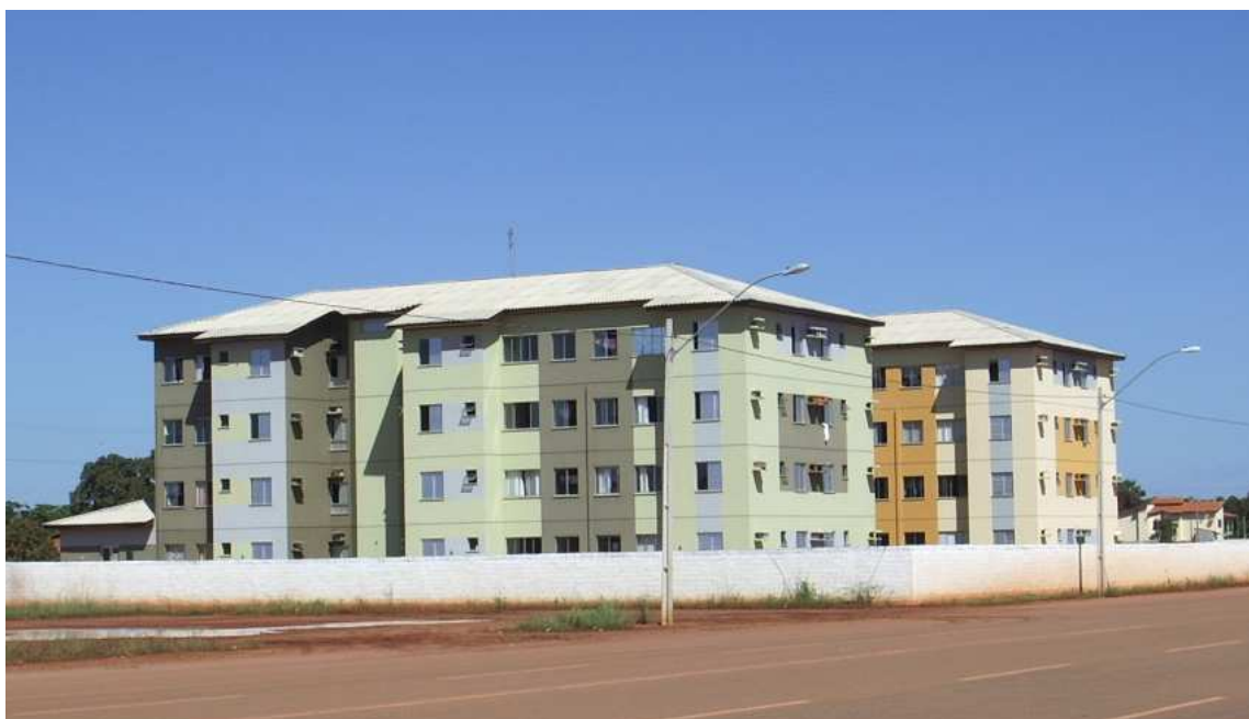
Foto 16: Vista do Residencial Rio Tocantins, construído através do Programa de Arrendamento Residencial – PAR na quadra ARSO 42, para famílias com renda até 4 S.M. (AMARAL, 2008).
