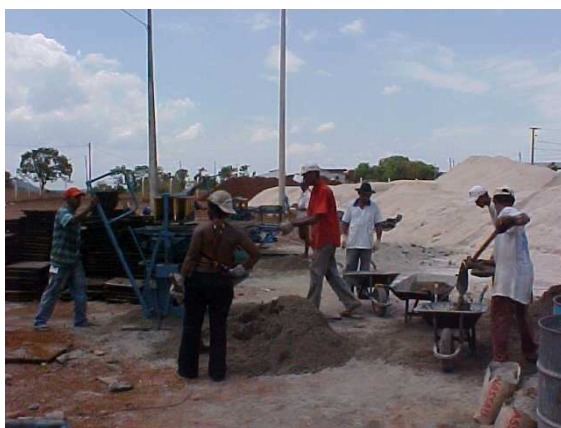
Fotos 25 e 26: Grupos de moradores produzindo blocos de concreto em instalação montada no interior da área do empreendimento. (Fonte: AMARAL, 2004)
