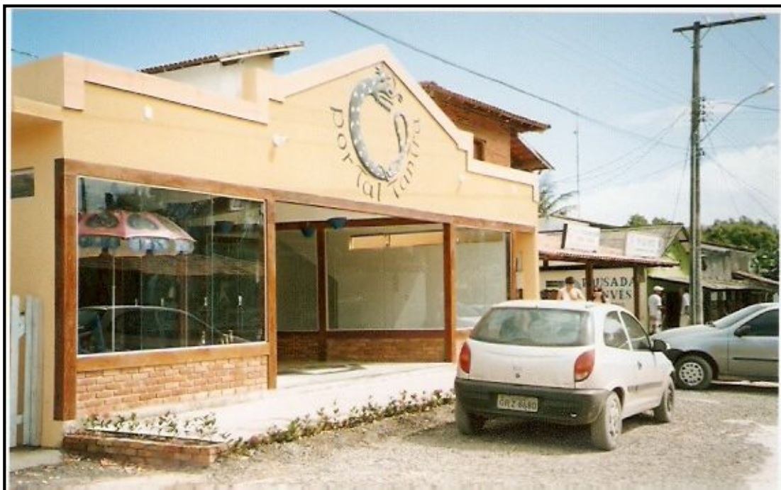
Figura 10: vista de um empreendimento comercial de “estrangeiros” na Vila de Itaúnas. O Posto farmacêutico se encontra à direita.
