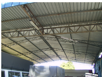
Fig. 3.11 – Cobertura em telha de aço
