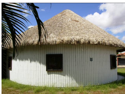
Fig. 3.14 – Cobertura de palha
