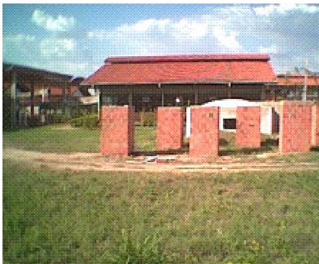
Figura 5.17 – Vista dos módulos (cabines)
