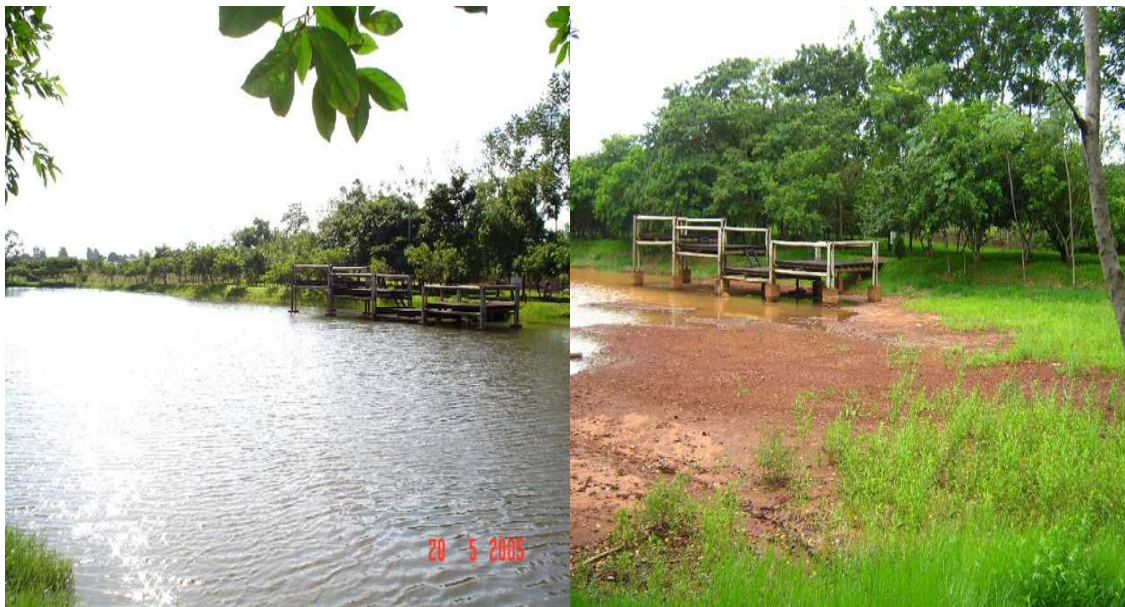
Figura 113: Ponte sobre o lago central da área de lazer Parque Iracema, em 2005 e 2009.
