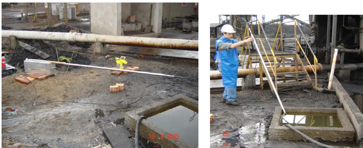
Figura 2.26 - Fotos da sonda com a fonte nos pontos de calibração.
