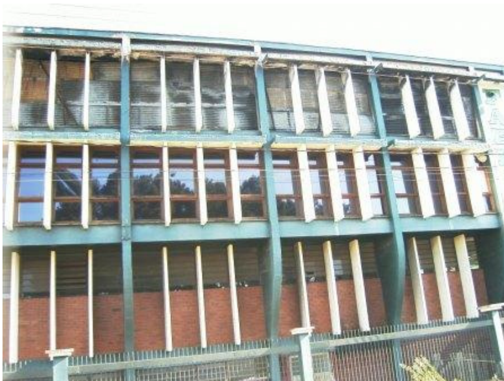
Figura 9 – Prédio abandonado de indústria calçadista fechada no bairro São Luis. Fonte: alunos EJA 7 a /8 a
