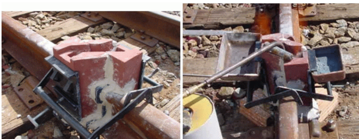
Figura 3.4 - Fotografias mostrando as etapas de selamento e pré-aquecimento.
