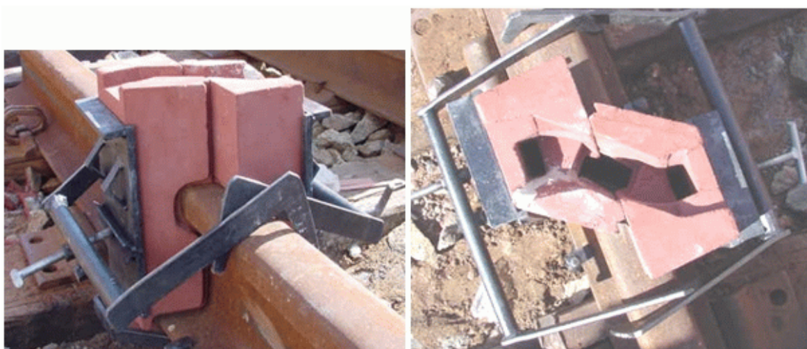
Figura 3.3 – Fotografias mostrando a instalação e a geometria do molde utilizado na solda em ângulo.
