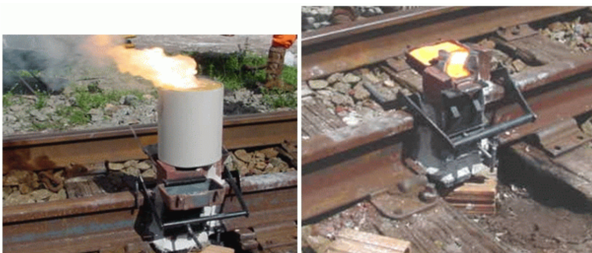
Figura 3.5 – À esquerda, ignição da reação aluminotérmica. À direita, solidificação da solda.
