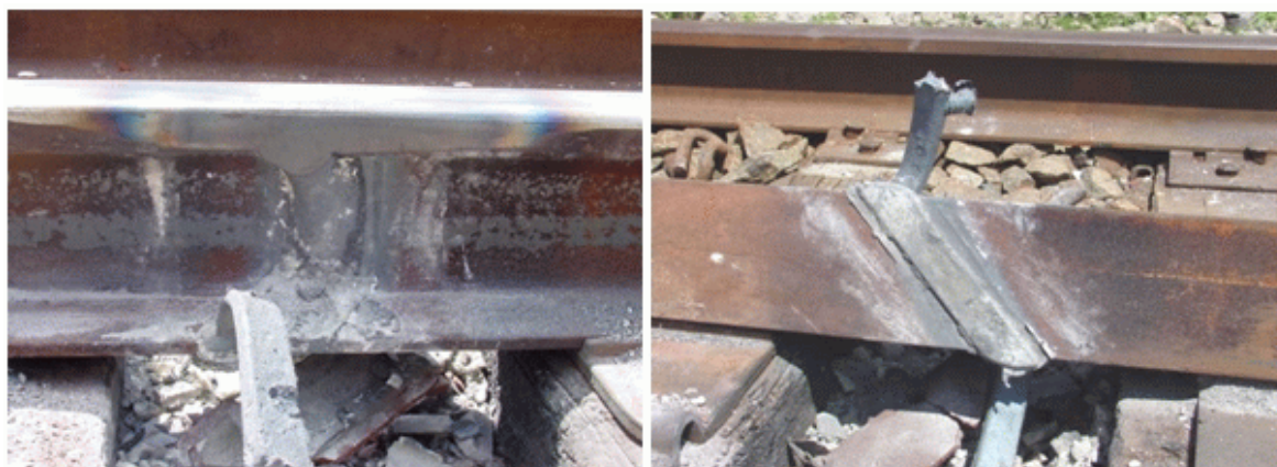
Figura 3.6 – Fotografias mostrando o acabamento e perfil final da solda em ângulo.
