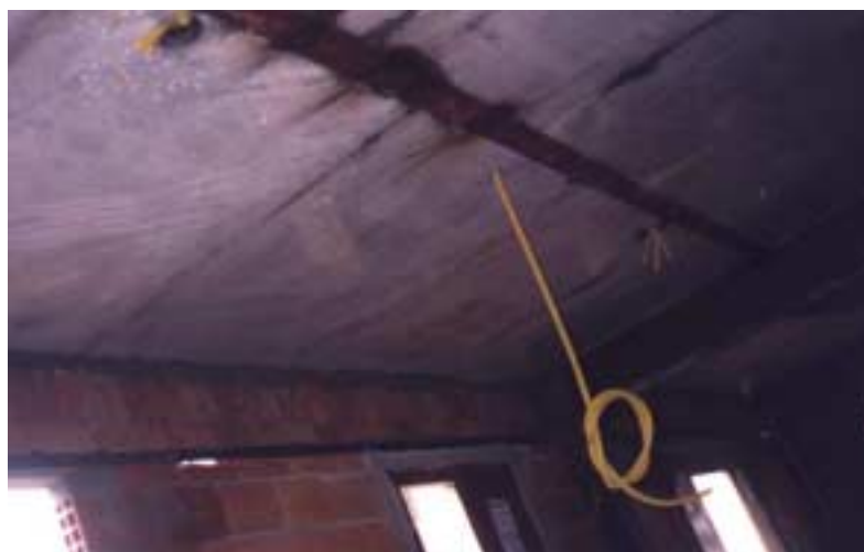
Figura 2.10 - Lajes em painéis pré-moldados de concreto
