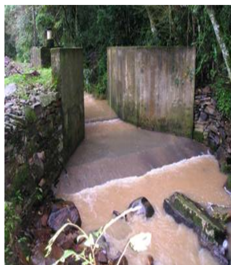
Figura 3.9: Calha Parshall de concreto.
