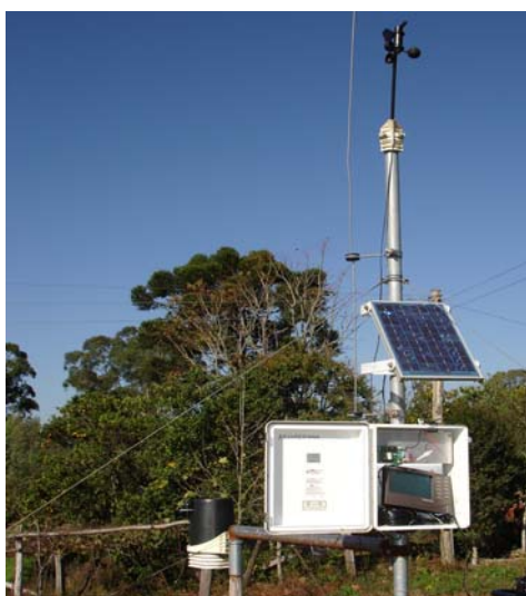
Figura 3.8: Estação meteorológica (Davis®) instalada na bacia de Arvorezinha.
