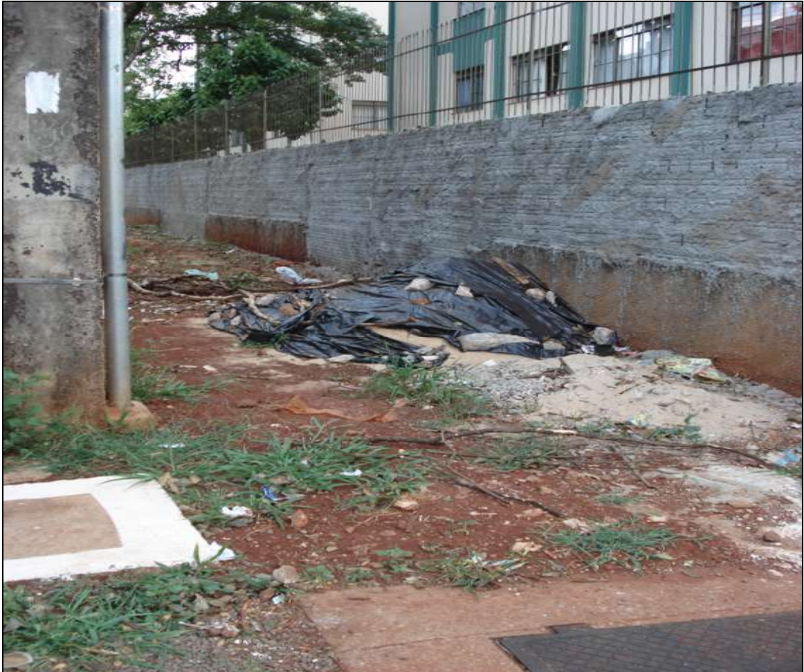
Figura 1.31) Presença de entulho, próximo ao Cemitério Municipal.
