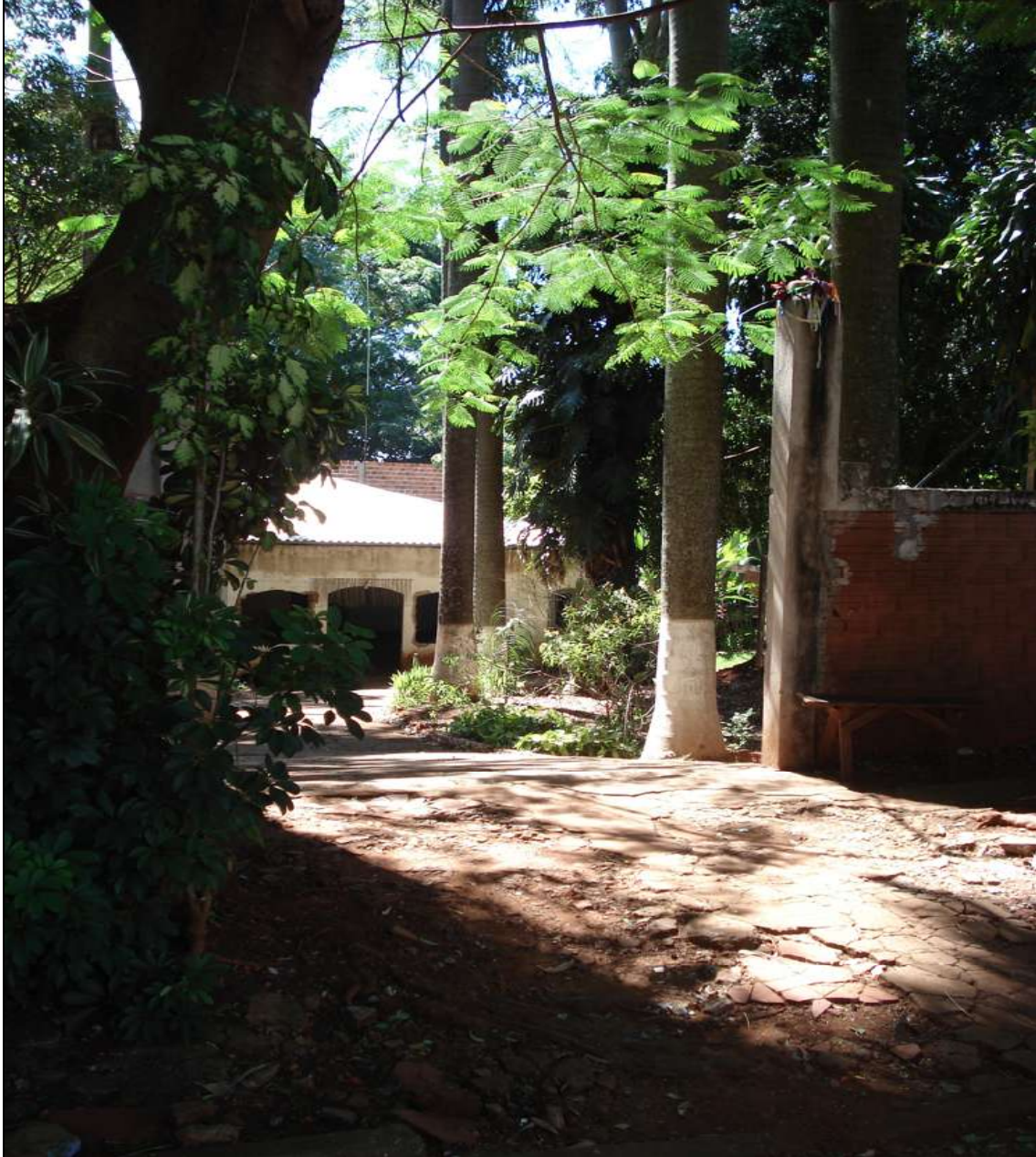
Figura 1.9) Residência de alvenaria, na área avaliada pelo questionário aplicado.
