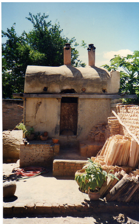
Figura 34 Forno de origem portuguesa com uma boca e entrada lateral para colocação das peças. Capacidade para seis dúzias de potes. Foto: Ceramistas.
