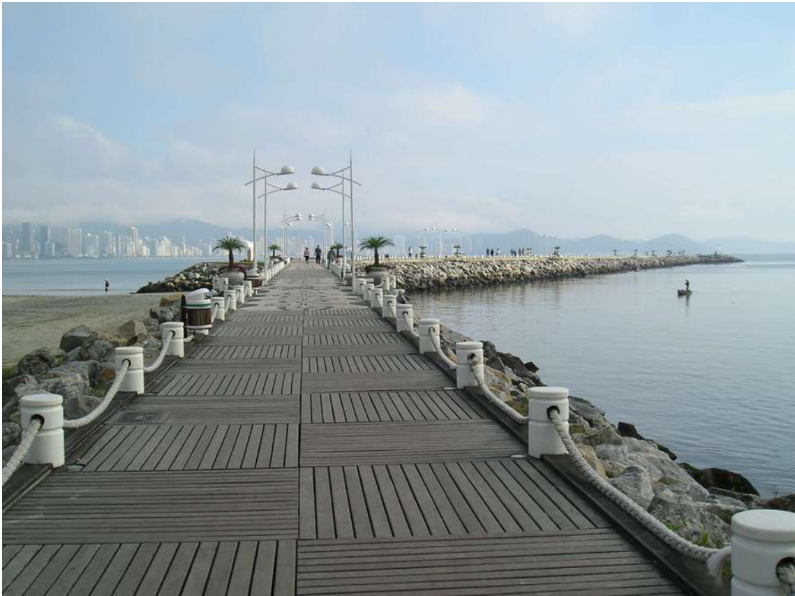
figura 10 – Molhe da Barra sul Implantando para amenizar o problema da erosão de praia, limitando o deslocamento transversal da areia para o Rio Camboriú. Hoje o molhe é um atrativo turístico de Balneário Camboriú. Fonte: fotografia da autora
