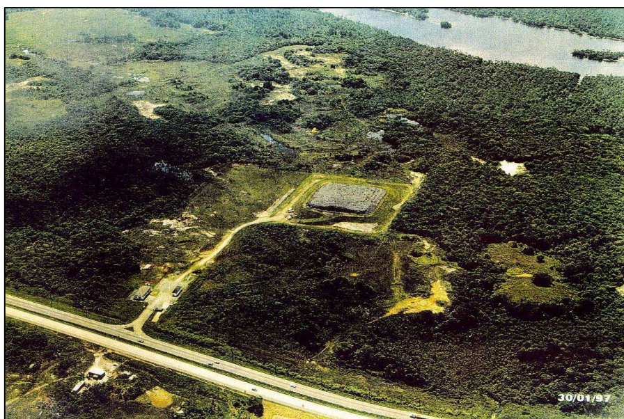
Figura 2: Estação de espera. Área de contenção de cerca de 33 mil toneladas de solo contaminado por organoclorados.
