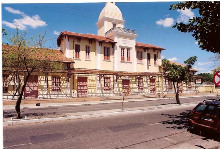
Figura 30: Estação Ferroviária Fonte: Sousa (2008)
