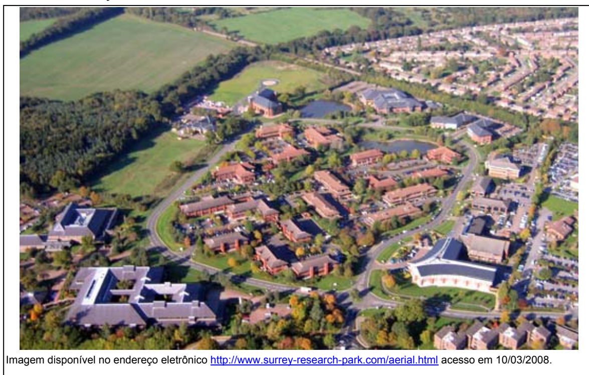
FIGURA 5.29 – Vista aérea do Surrey Research Park
