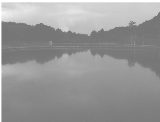
Figura 5 – ETE de São Lourenço da Serra, SP - Lagoa Facultativa. Tratamento secundário.
