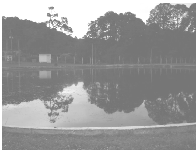
Figura 4 – ETE de São Lourenço da Serra, SP - Lagoa Anaeróbia. Tratamento primário.
