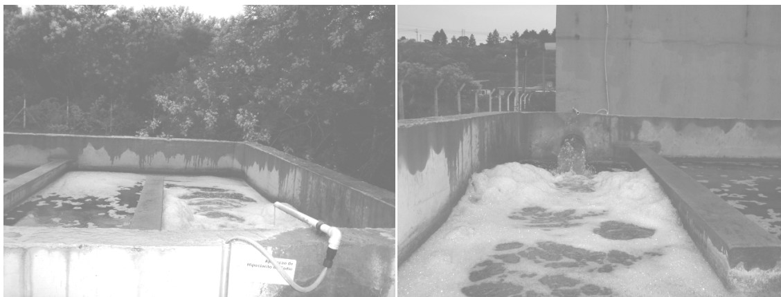
Figura 8 – ETE de Jquitiba, SP - Tanque de cloração.
