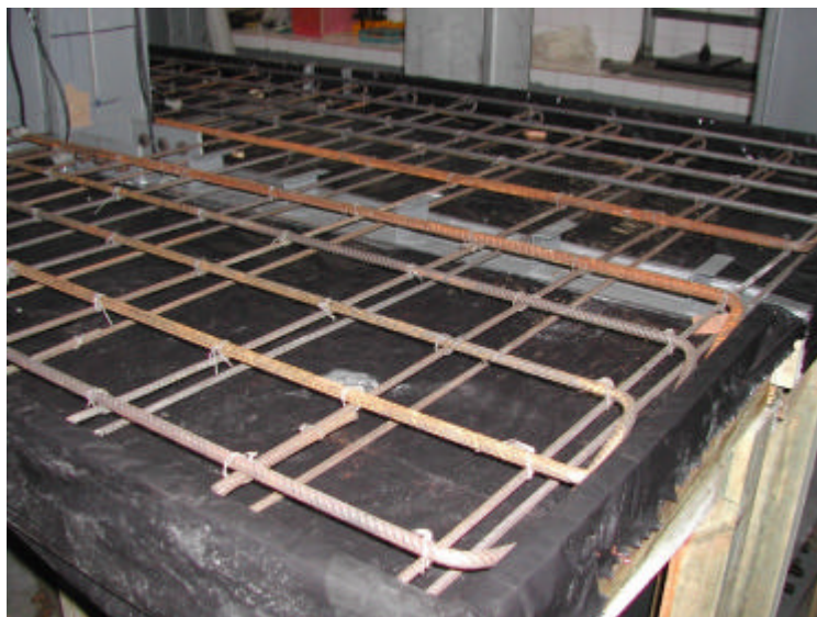
Figura 4.22 – Foto das armaduras do ensaio E1 do Protótipo B.
