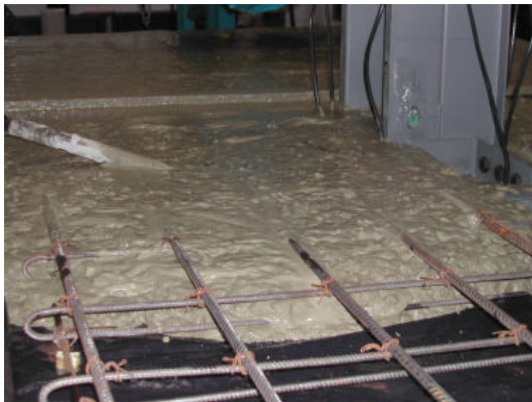
Foto 5 – Concretagem da laje.
