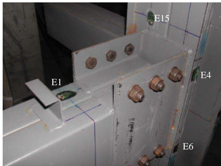
Figura 4.19 – Foto do posicionamento dos extensômetros elétricos de resistência E1, E4, E6 e E15.
