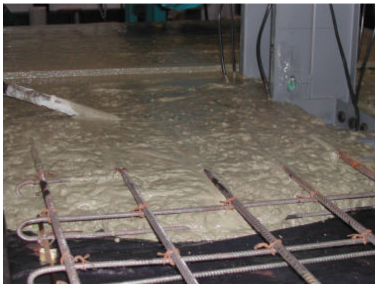
Figura 4.24 – Foto da concretagem do ensaio E1 do Protótipo C.
