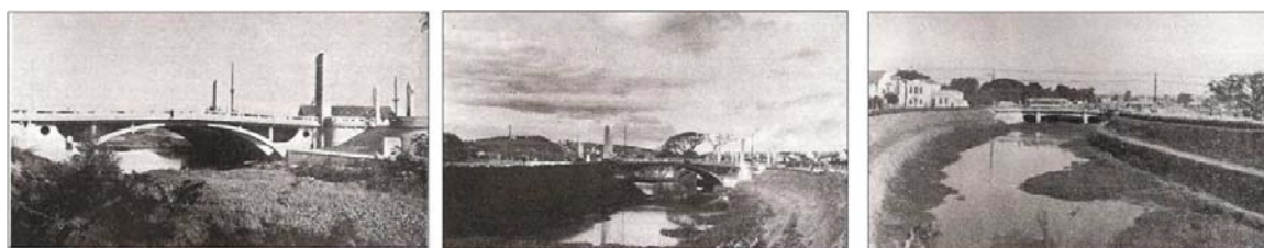
Obras executadas até 1942, sob a administração de Loureiro da Silva, relativas à Canalização do Riacho. Fonte: SILVA (1943). Op. Cit. Fig. 54- Nova ponte: Avenida Getúlio Vargas. Fig.55- Nova ponte: Avenida João Pessoa. Fig.56- Trecho do Riacho canalizado junto à ponte da Azenha.
