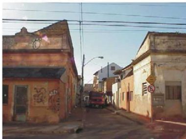
Fig. 108- Edificações tombadas pelo Patrimônio Histórico em primeiro plano. Perspectiva geral da Rua Luiz Guaranha.
