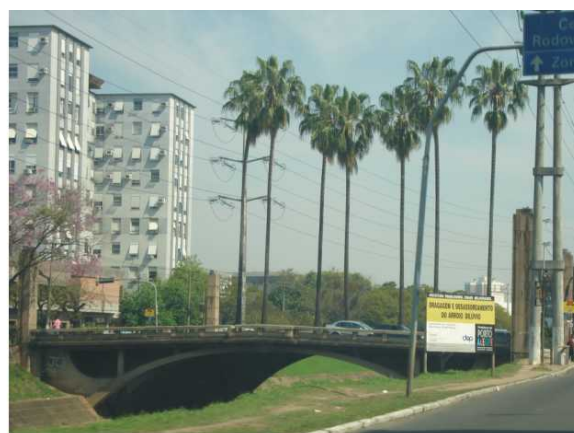
Fig. 154- Avenida Ipiranga: Ponte sobre a Avenida João Pessoa. Destaque para os pilones de amarração de embarcações. Foto da autora, 2008.
