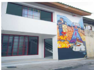
Fig. 113- Nova Sede da Associação de Moradores.
