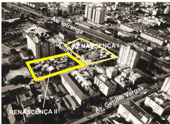
Fig. 131- Vista aérea das Vila Renascença I e II, 1992.
