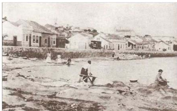
Fig. 13- Imagem da Praia do Riacho no final do século XIX. Ao fundo, a Rua Washington Luís, conhecida como Rua da Praia do Riacho. Fonte: PESAVENTO (1992). Op. Cit.
