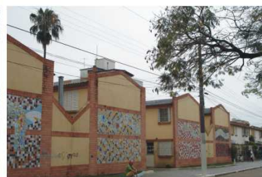
Fig. 144- Detalhe das fachadas do Condomínio. Foto da autora, 2008.
