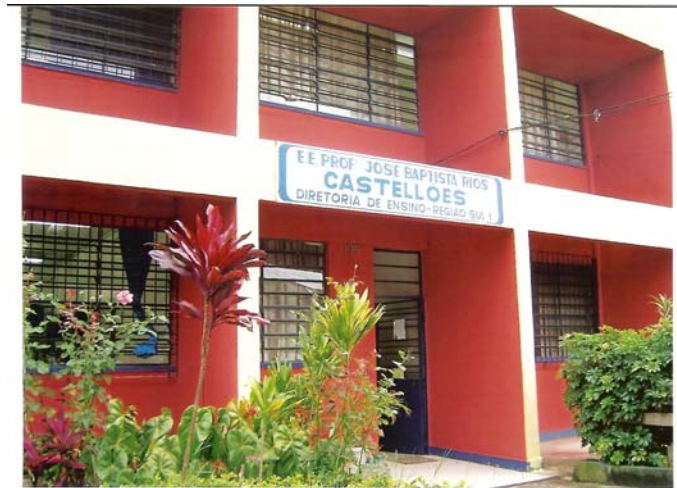
Foto 1: Fachada da escola
