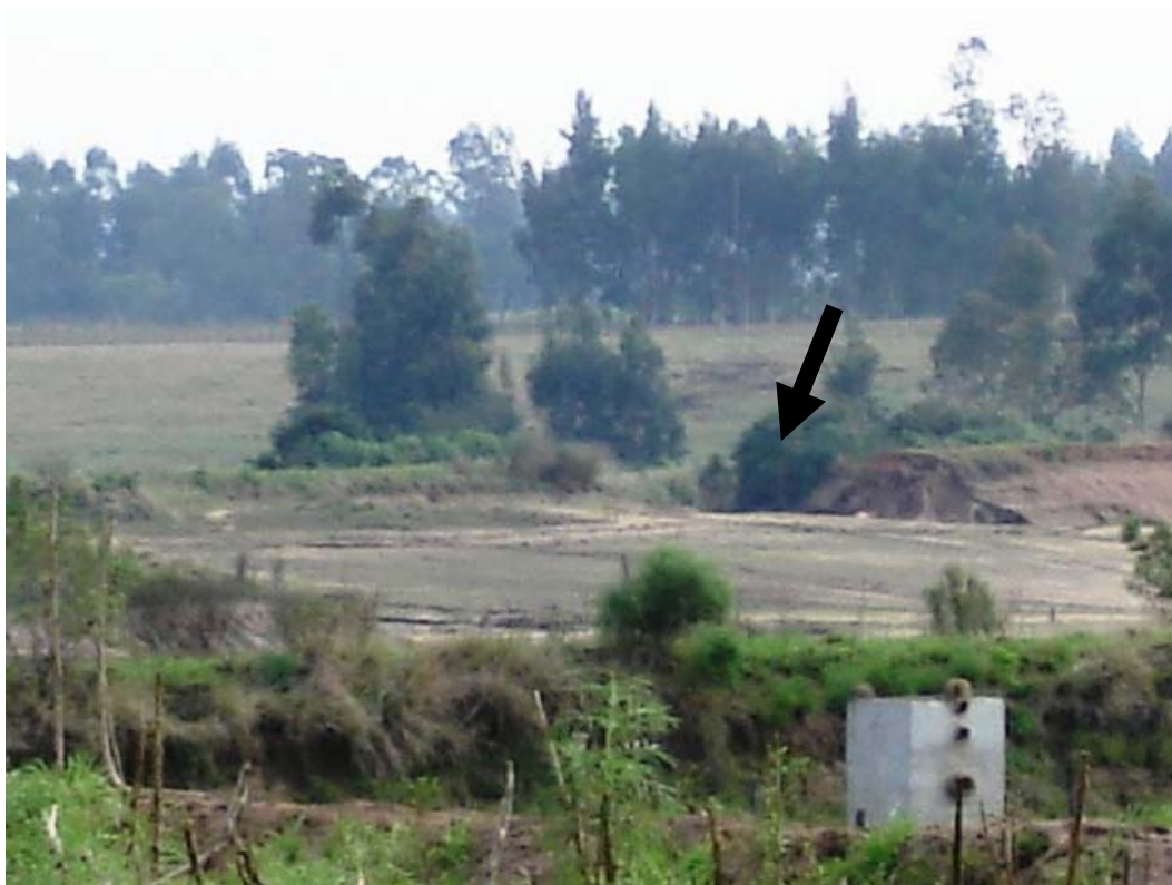
Figura II-4. Detalhe de talude rompido (seta) após forte chuva.
