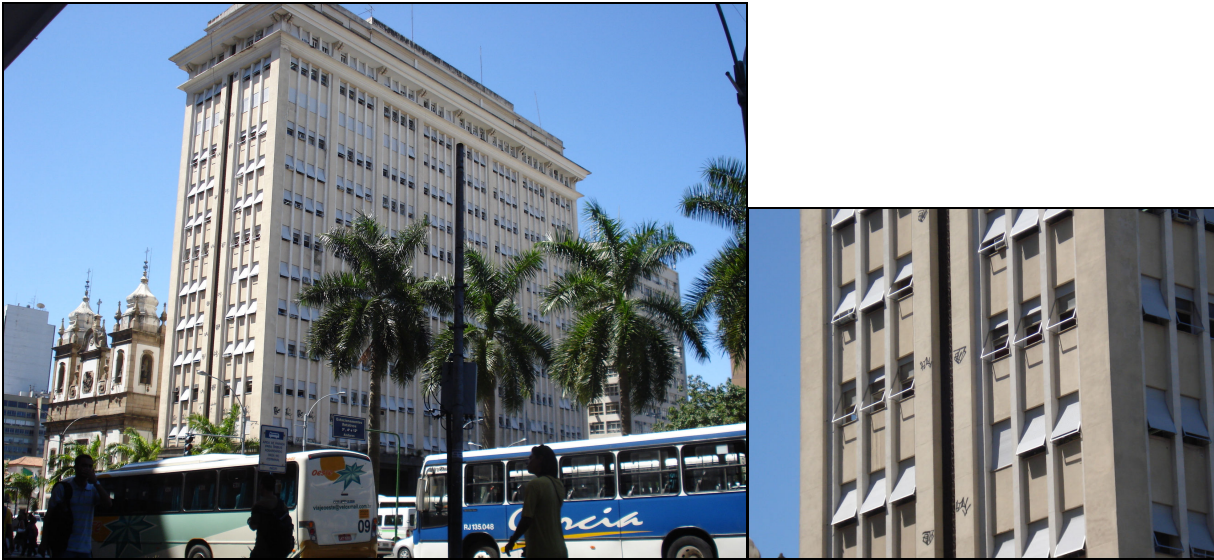
Figura 9. Edifício não selado. Na foto menor, detalhe da fachada, mostrando as janelas abertas
