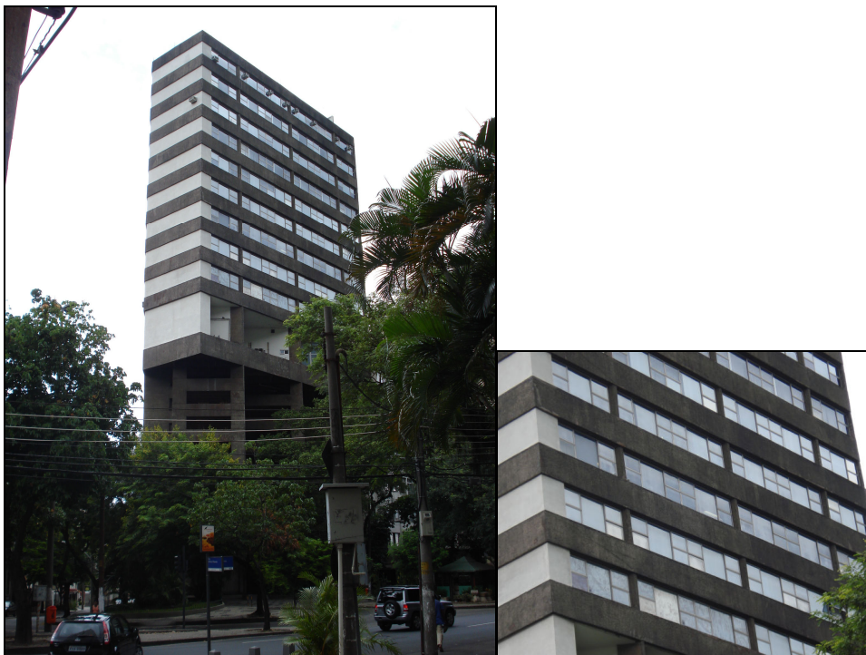
Figura 7. Edifício selado. Na foto menor, detalhe da fachada, mostrando as janelas seladas
