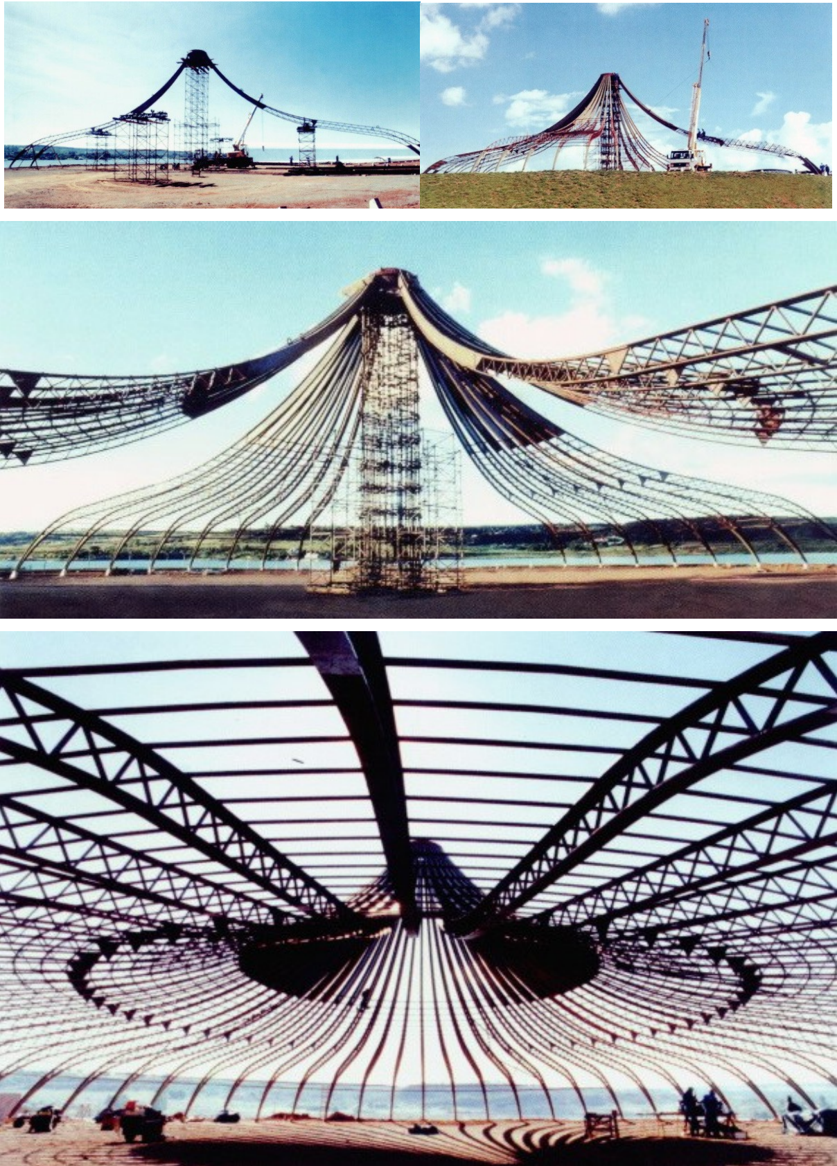
Figura 4-14 – Montagem da estrutura. Fonte: MATTOS (2001).
