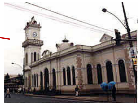
ESTAÇÃO FERROVIÁRIA DE JUIZ DE FORA (E.F.C.B.)
