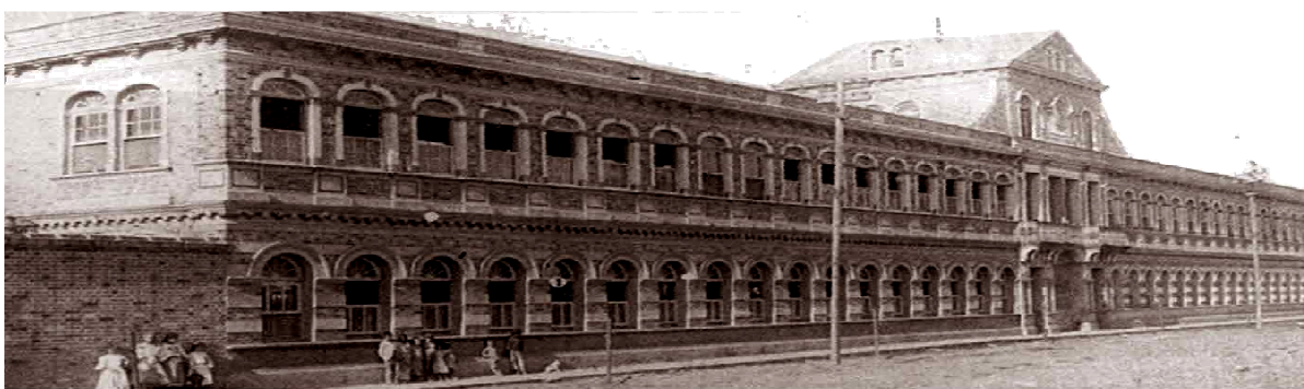
Fábrica Bernardo Mascarenhas – fachada principal - final do século XIX.
