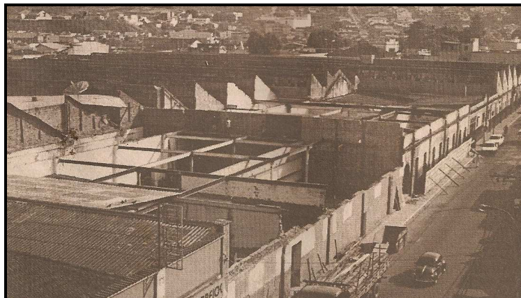
Figura 2: a derrubada dos telhados sheds
