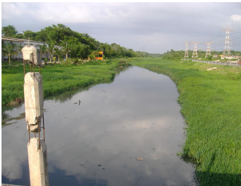
Fotografia 22: campanha para evitar que os moradores jogassem lixo às margens do canal São Joaquim
