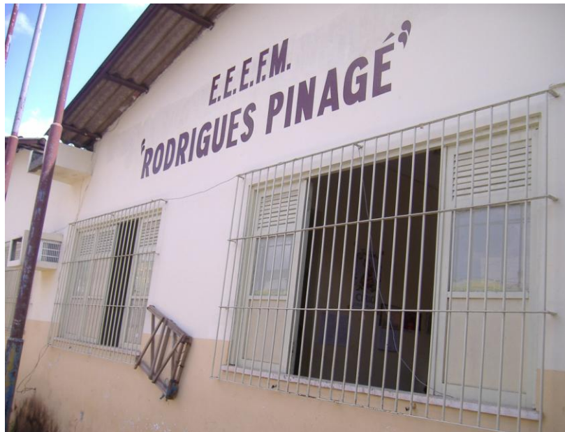
Fotografia 23: Parceria com a comunidade que deu certo Fonte Monteiro (2008)
